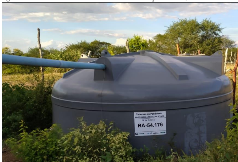
Figura 23- Santo Estevão: Modelo de cisterna de polietileno, comunidade do Paiaíá, 2020
