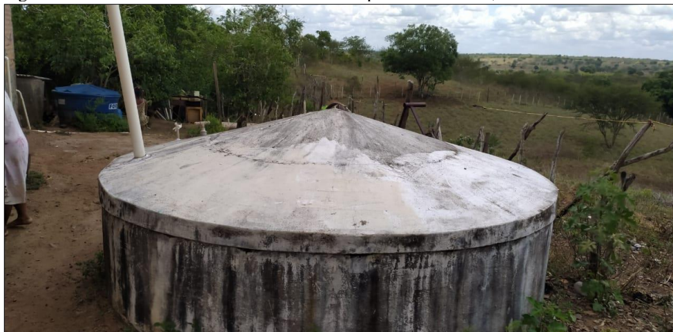
Figura 22- Santo Estevão: Modelo de cisterna de placa de cimento, comunidade rural do Paiaíá, 2021
