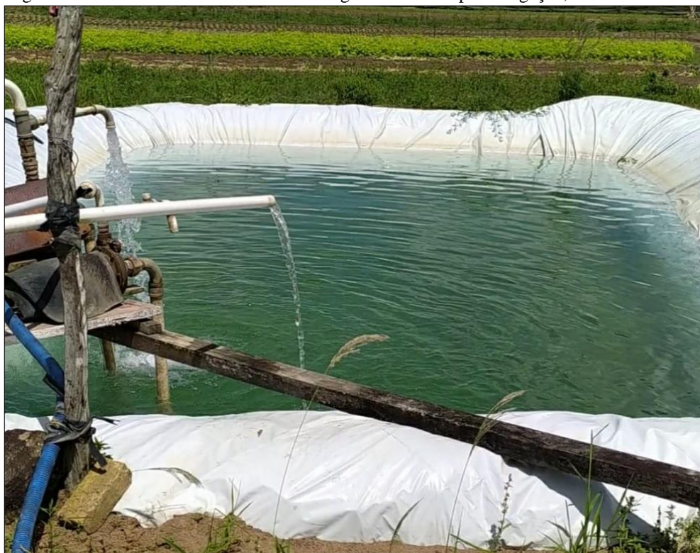
Figura 18- Santo Estevão: Reservatório de água de cisterna para irrigação, 2020
