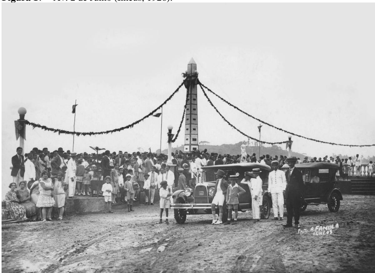
Figura 17 – Av. 2 de Julho (Ilhéus, 1926).
