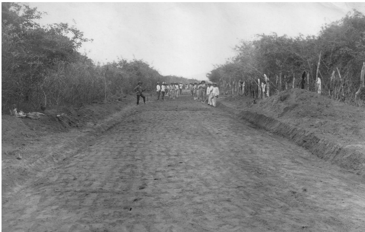
Figura 22 – Trabalhadores abrindo a estrada no trecho de Bonfim a Canoa.
