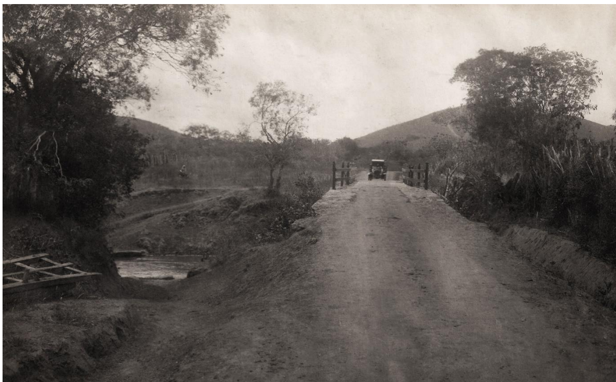
Figura 24 – Ponte sobre o rio Itapicuru no km 13.
