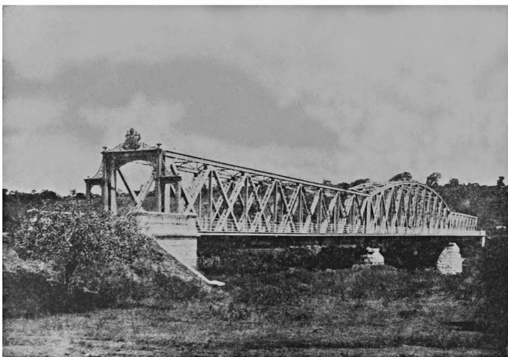
Ponte Rio Branco (vista de lado)
