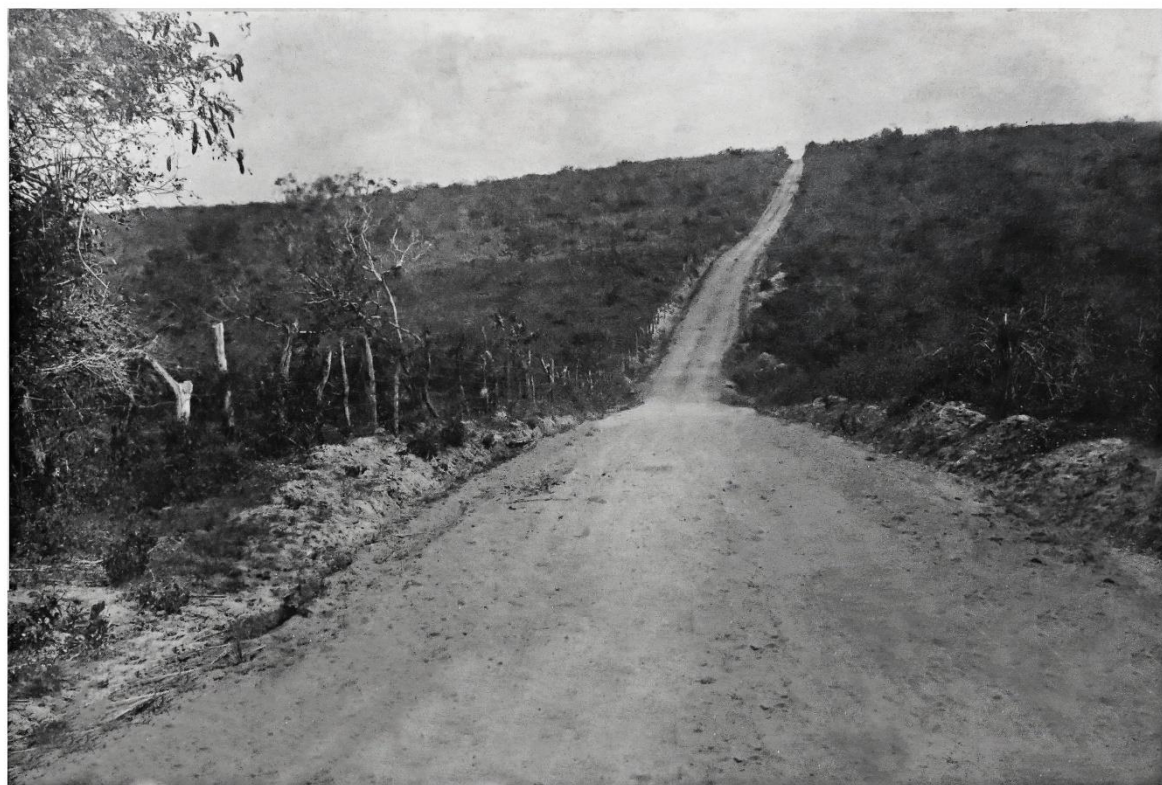
Figura 26 – Trecho do km 4.
