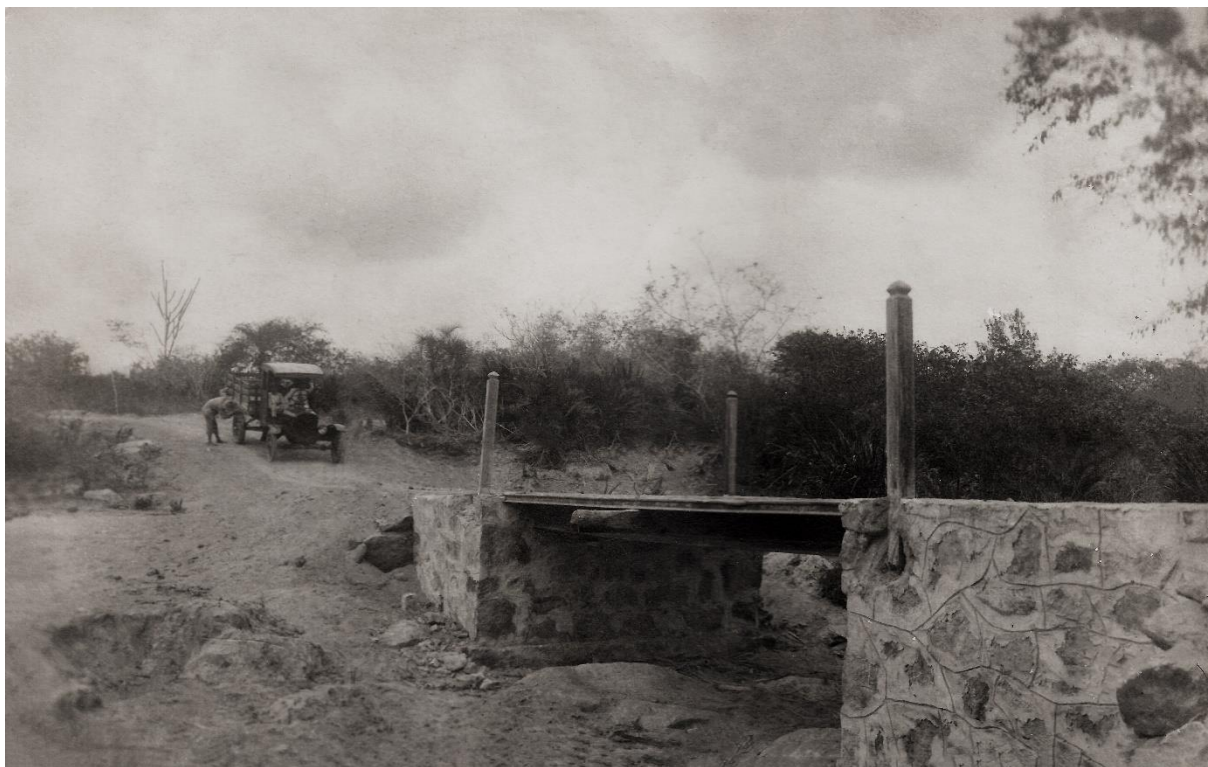
Figura 25 – Ponte sobre o rio Maria Preta no km 20.
