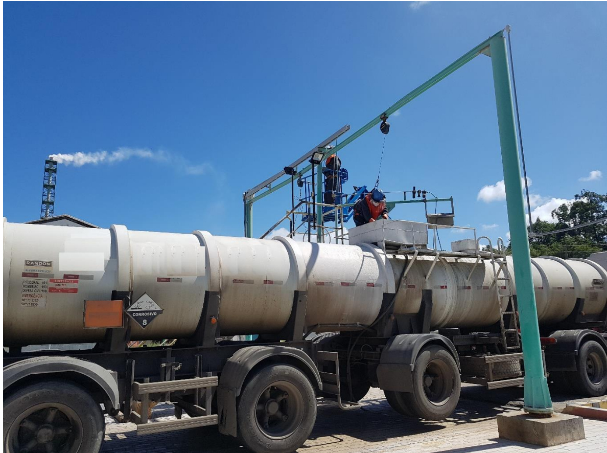
Figura 18. Atividade de inspeção do tanque, atividade esta sendo realizada na plataforma.
