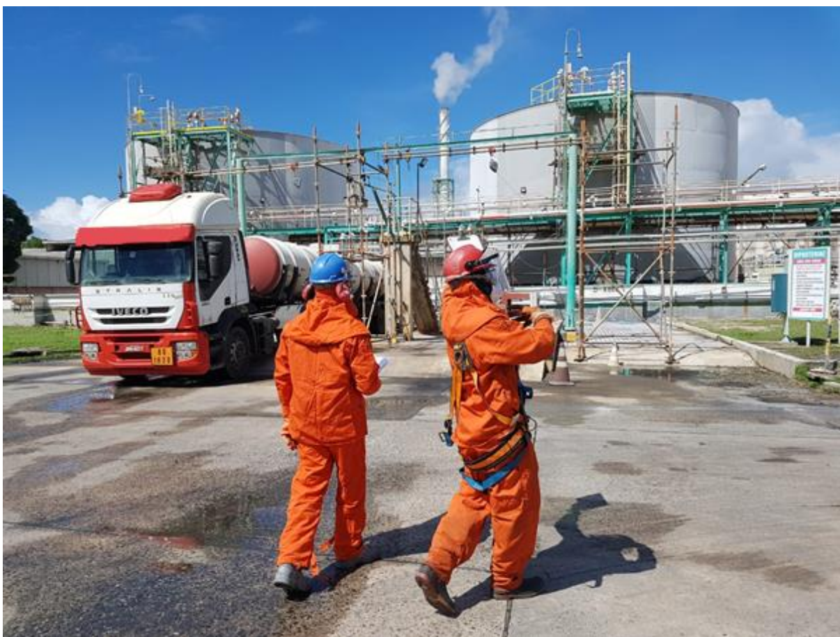
Figura 11. Iniciando o procedimento de descarga de ácido, onde é possível perceber os funcionários usando os EPIs necessários.
