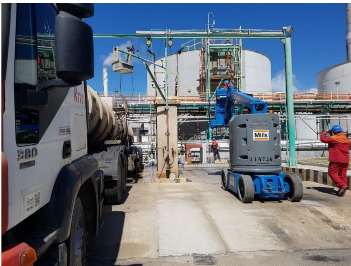
Figura 10. Estação de descarga dos caminhões.
