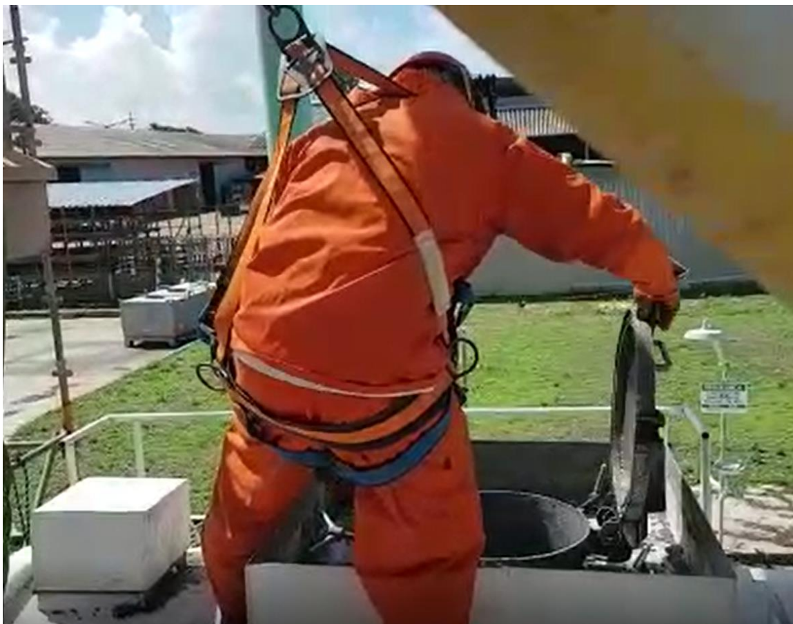
Figura 19. Operador abrindo a boca de visita, atividade esta de inspeção sendo realizada na plataforma.
