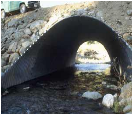
Fig.08 - Colocação Adequada de Bueiro (a) e viaduto em áreas sensíveis (b).
