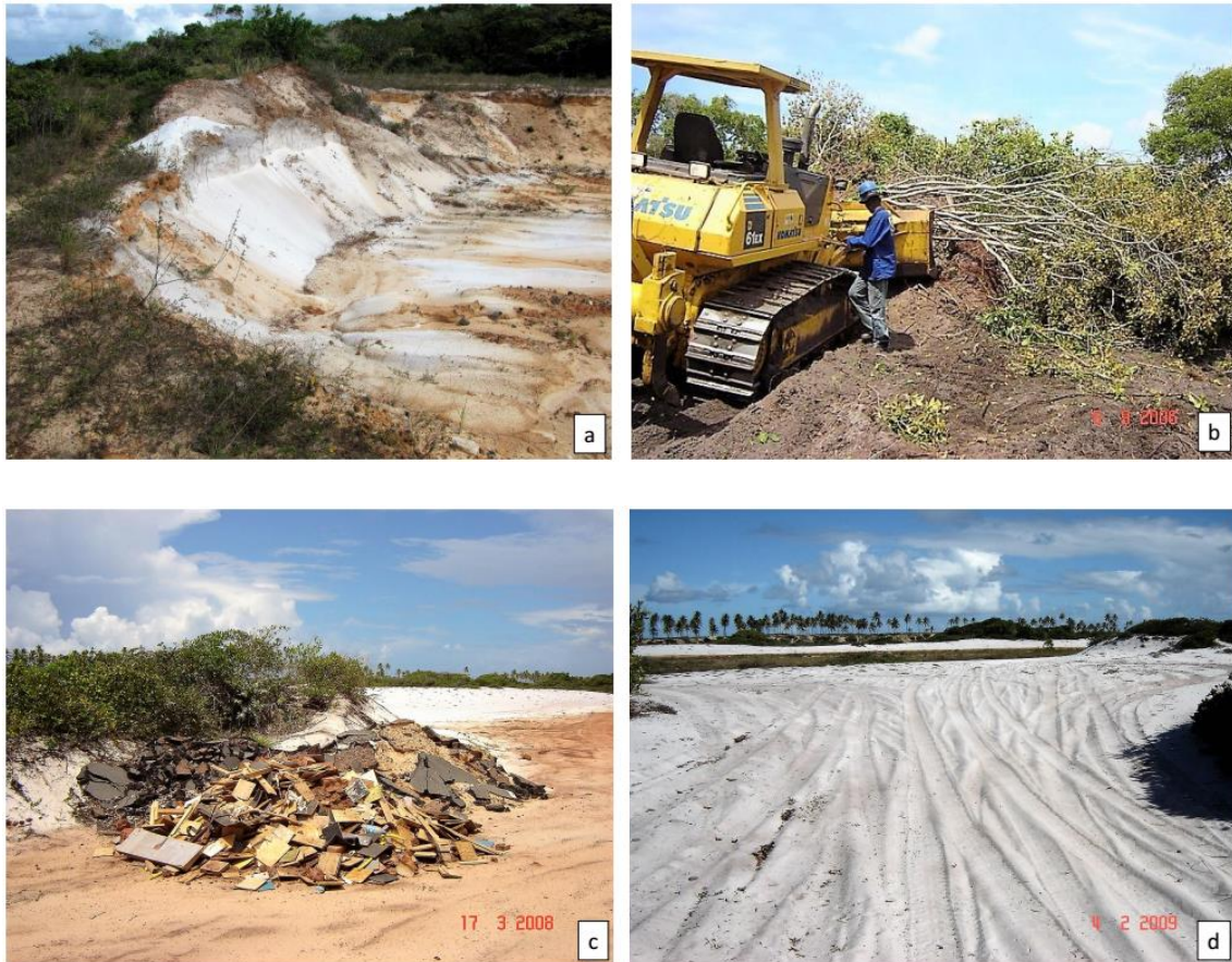
Figura 1 – Impactos ambientais sobre a restinga no Litoral Norte da Bahia. a. Retirada de areia para construção civil. b. Supressão da vegetação nativa. c. Disposição irregular de resíduos sólidos de obras. d. Circulação de veículos fora de estrada sobre as dunas. (Fotos – Danilo Lima).
