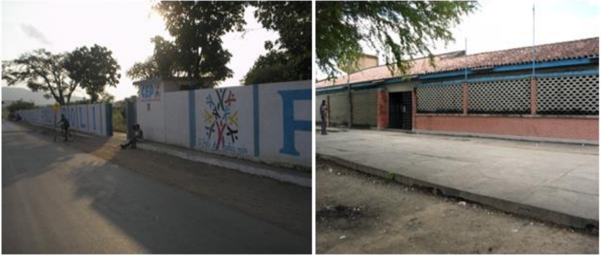
Figuras 1 e 2: Muro externo e fachada interna.do colégio.
