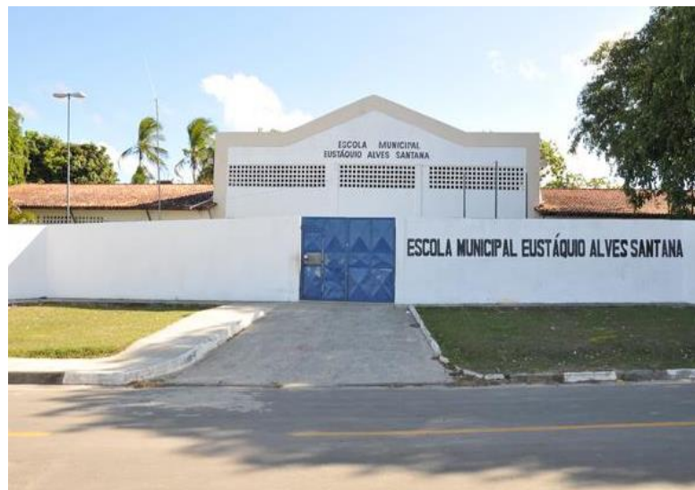
Figura 2 – Fachada da instituição em 2015.
