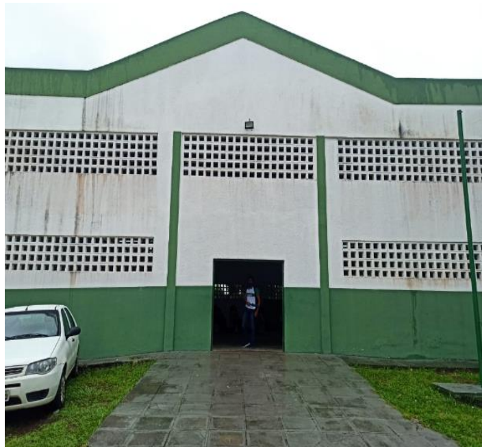
Figura 9 – Portão principal que dá acesso à escola.
