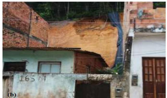
**Fig. 7.24:** (a) Talude de corte na base da encosta, com cicatriz de deslizamento, a menos de 1m da moradia. 26-São Cipriano (564246mE/8572141mN). (b) Talude de corte na base da encosta, muito próximo da ocupação, 19-Novo Horizonte II (561167mE/8569175mN).
