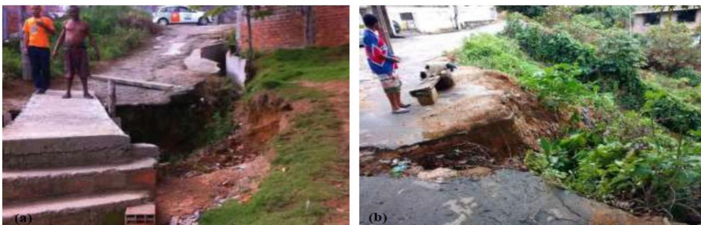
**Fig. 7.28:** (a) Lançamento de esgoto na encosta e processo erosivo linear, 28-Vilamar (563794mE / 8571241mN). (b) Lançamento concentrado de águas pluviais no talude, 10-Novo Horizonte I.
