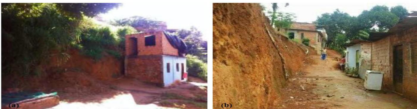
**Fig. 7.25:** (a) Construção de aterro lançado em encosta invadida pela ocupação em Beira Dique-06 (557291mE/8571270mN). (b) Aterro lançado construído para assentamento de moradia em Calabetão-11 (557788mE/8570001mN)
