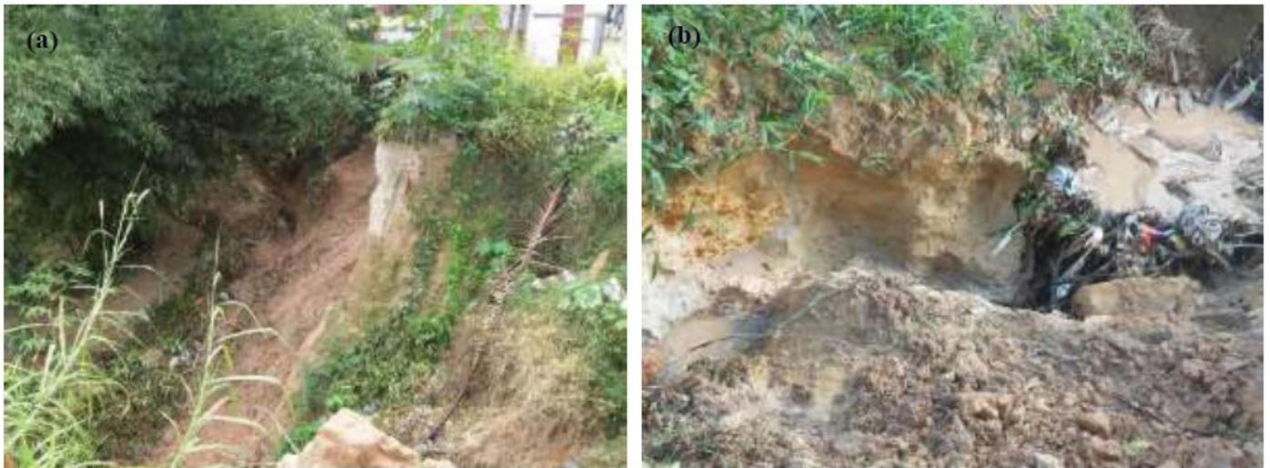
**Fig. 7.17:** (a) Trinca na encosta, evidenciando carácter expansivo do solo, 25-Sabiá; (b) Trinca em moradia, dano provocado pelo movimento do solo expansivo, Subúrbio ferroviário.
