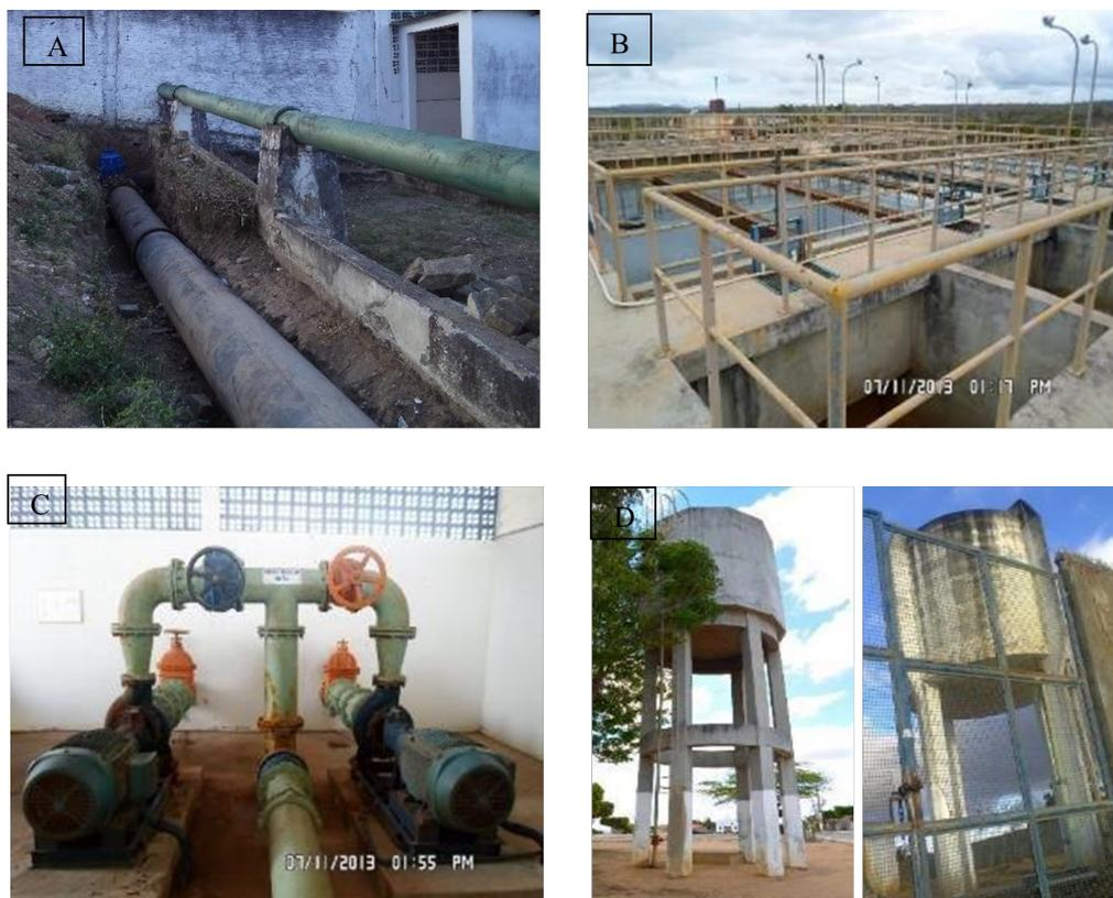
**Fig. 9.1** – Sistema Integrado de Abastecimento de Água de Poções e Bom Jesus da Serra: Adutora (A), ETA (B), Estação Elevatória (C) e Reservatórios Elevados (D) . Fonte: PMSB de Poções – BA, 2015.
