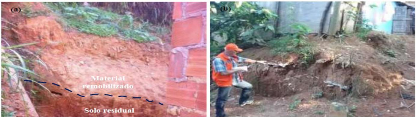
**Fig. 7.14:** Talude de corte ilustrando cobertura de material remobilizado constituído por mistura de solo e lixo, 11-Calabetao (557659mE/8570115mN). Corte em encosta mostrando material remobilizado sobre o manto de alteração, 16-Mamorana
