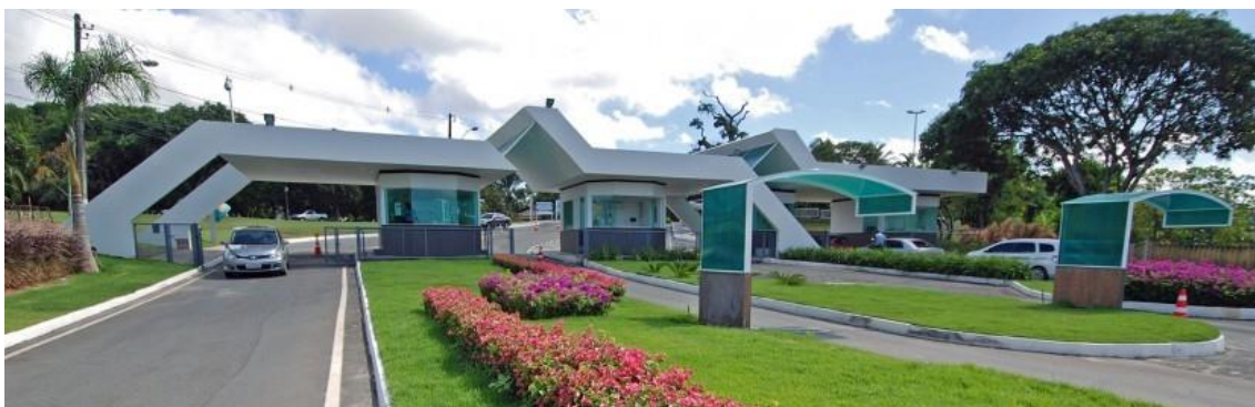
Figura 5 – Fotos do Condomínio Parque Encontro das Águas (Região 1)
