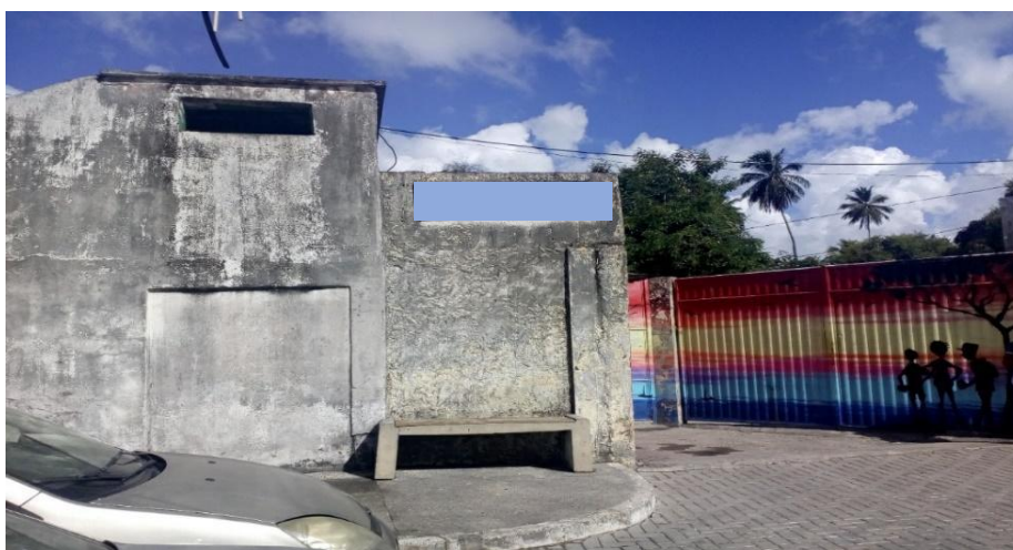
Figura 2 - Fachada da unidade escolar. Salvador, Bahia, Brasil, 2022.
