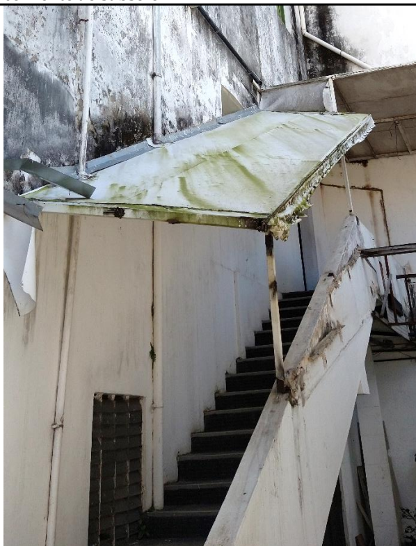
FOTO 99: Escada externa em concreto do térreo do convento ao subsolo
