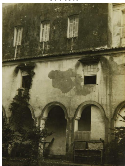
Figura 106- Trecho da fachada sudeste
