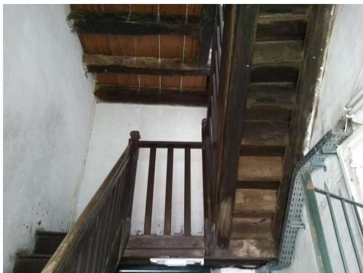
FOTO 93: Escada de acesso à Torre Sineira
