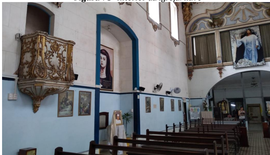
Figura 75- Interior da igreja: nave
