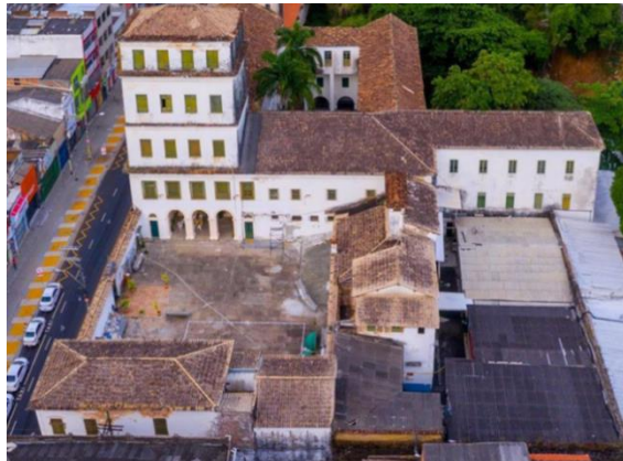
Figura 126- Vista dos anexos construídos recentemente e ao fundo do convento
