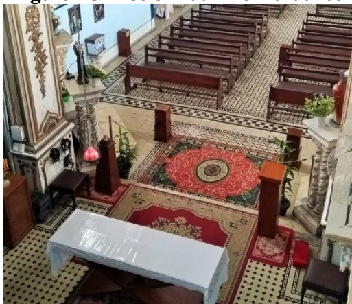
Figura 43- Piso em ladrilho hidráulico
