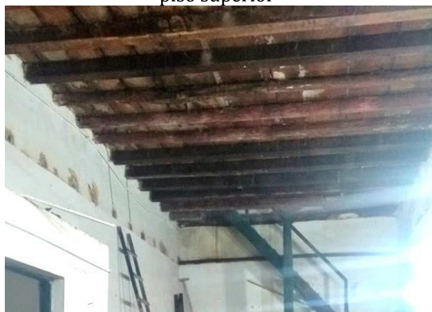
Figura 34- Barrotes de suporte do assoalho no piso superior
