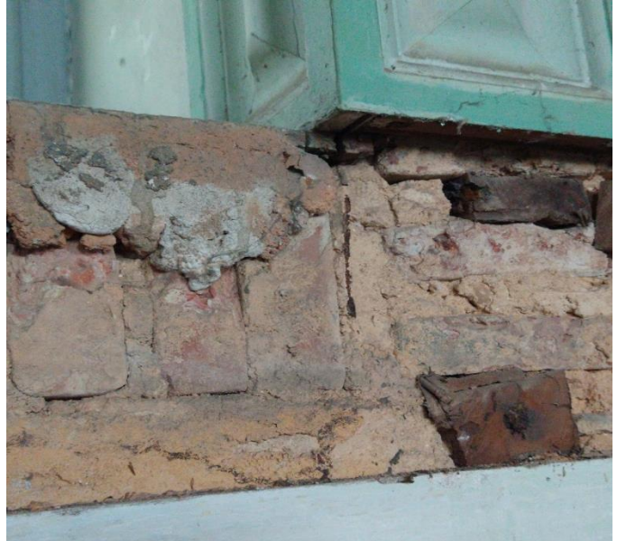
Figura 63- Vão de janela em tijolinho
