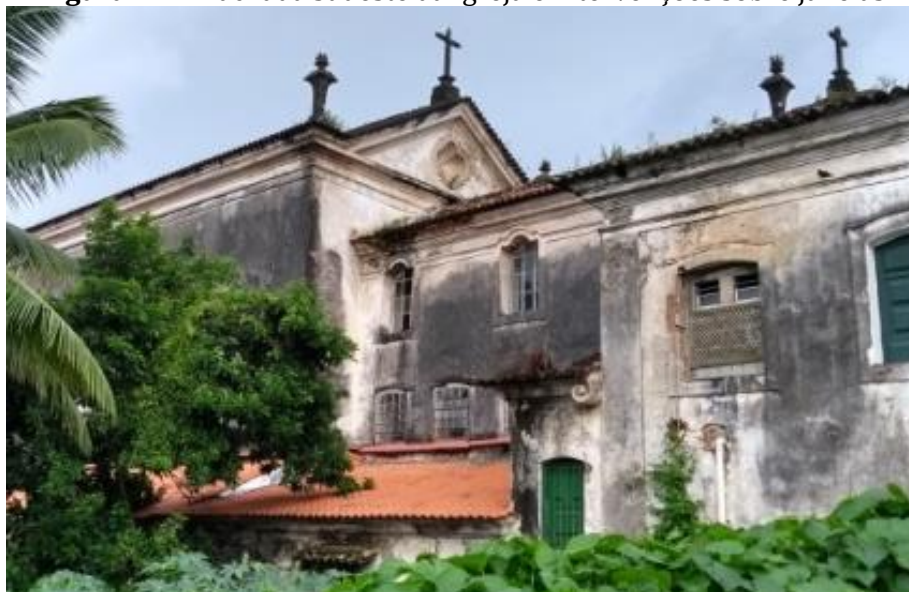
Figura 122- Fachada sudeste da Igreja e intervenções sobre janelas
