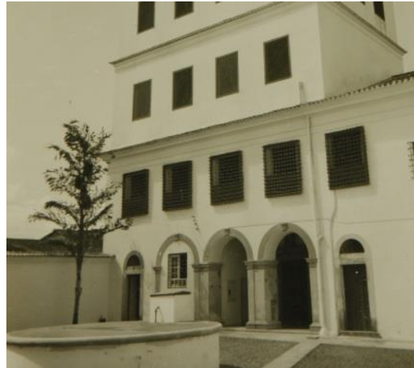
Figura 59- Arcada em cantaria: pátio de acesso ao convento
