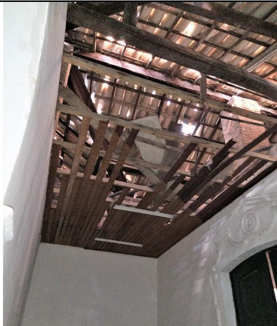
FOTO 69 E FOTO 70: Cobertura do volume do fundo: vê-se a cumeeira, os pontaletes e o rincão
