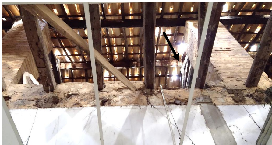
FOTO 64 e 65: Pontaletes em tijolo maciço sobre alvenaria de pedra, apoiando as vigas e tesouras do telhado
