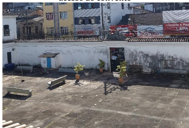
Figura 38- Piso cimentado do pátio externo de acesso ao convento
