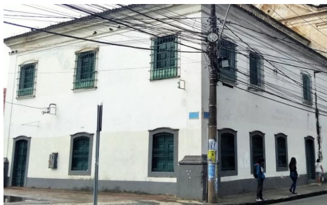
Figura 65- Janelas e portas em arco abatido: fachada nordeste da igreja
