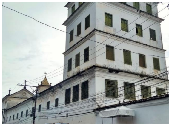
Figura 57- Janelas do convento em verga reta na fachada noroeste
