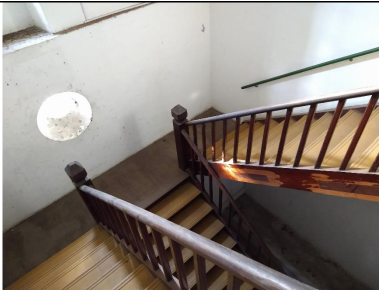
FOTO 98: Escada em madeira do térreo ao 1º pav. do convento
