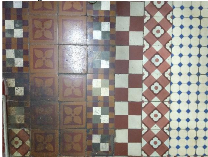
Figura 42- Piso em ladrilho hidráulico
