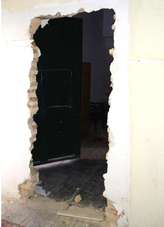
Figura 22- Trecho demolido de alvenaria
