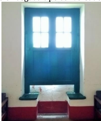
Figura 56- Janela em verga reta meio-rasgada tipo conversadeira
