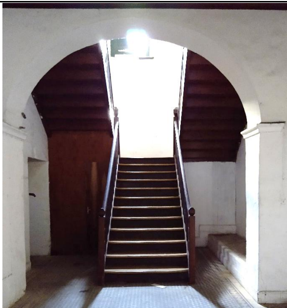
FOTO 97: Escada em madeira do térreo ao 1º pav. do convento
