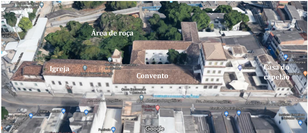
Figura 13- Fachada principal do conjunto e a relação de seus volumes construtivos
