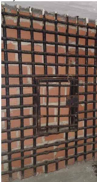
Figura 24- Vedação em tijolo cerâmico furado
