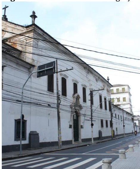
Figura 120- Vista externa da igreja
