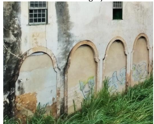
Figura 71- Arcada em arco joanino: subsolo da igreja
