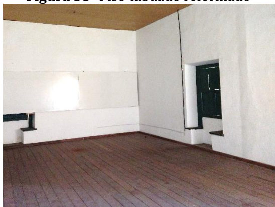
Figura 35- Piso tabuado reformado
