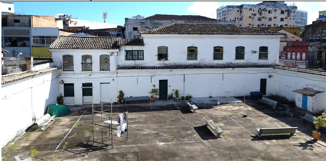
FOTO 63: Cobertura da casa do capelão e dos muros
