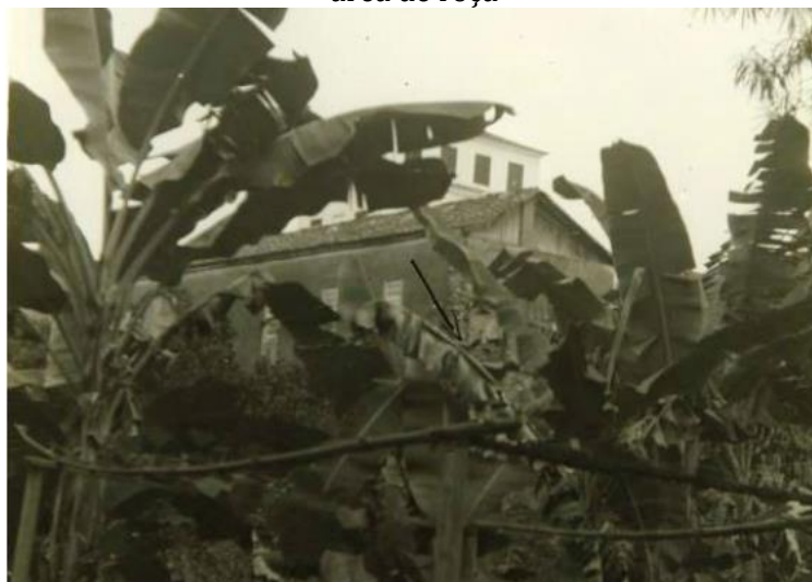
Figura 107- Vista do trecho da fachada sudeste, desde a área de roça
