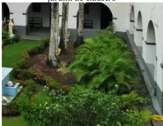
Figura 37- Piso cimentado e área de jardim do claustro
