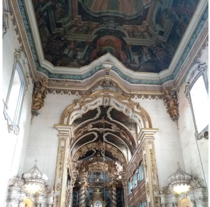
Figura 52- Forro da nave e capela-mor
