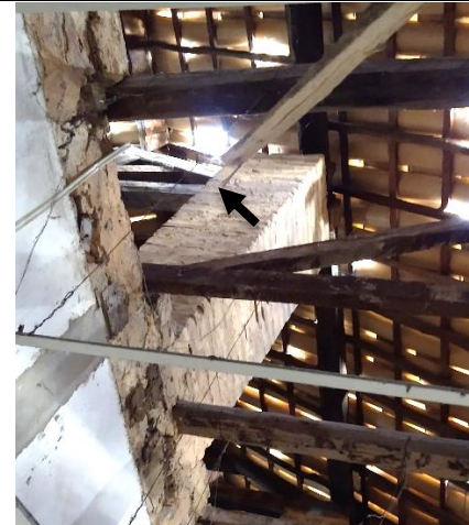
FOTO 64 e 65: Pontaletes em tijolo maciço sobre alvenaria de pedra, apoiando as vigas e tesouras do telhado
