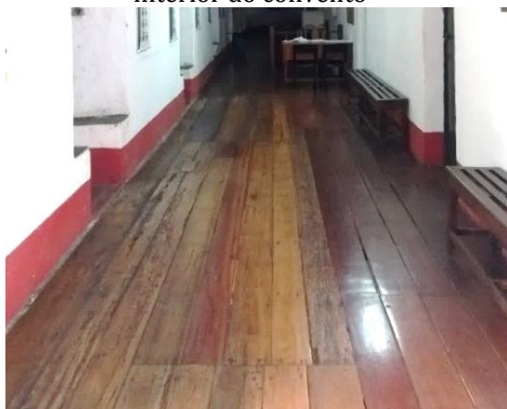
Figura 33- Exemplo de piso tabuado no interior do convento
