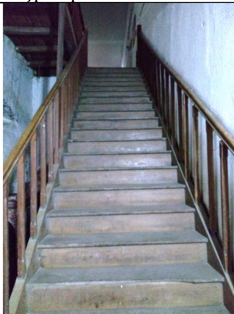
FOTO 96: Escada em madeira do térreo do convento (ao fundo) para o pátio do subsolo
