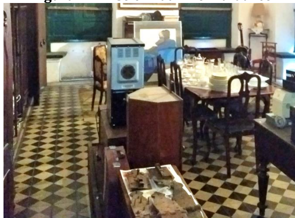
Figura 44- Piso em ladrilho hidráulico
