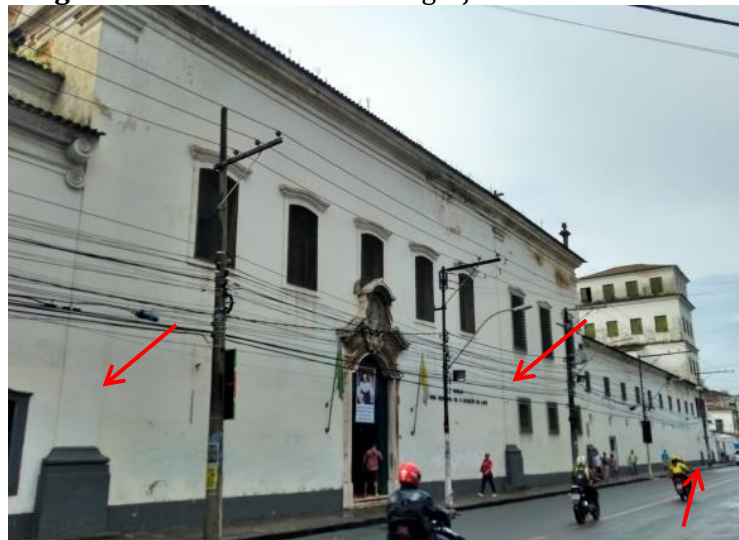
Figura 17- Fachada Noroeste: igreja e mirante ao fundo
