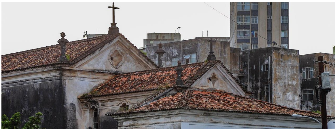
Figura 30- Coberturas da igreja: nave à esquerda, capela-mor e sacristia à direita
