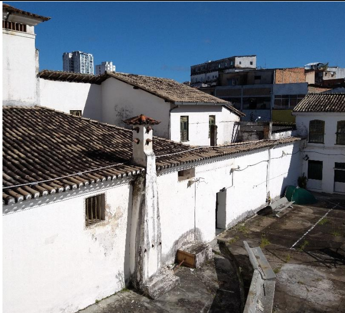
FOTO 61 e FOTO 62: Lateral do convento com muro e anexos. Destaque para as duas chaminés
