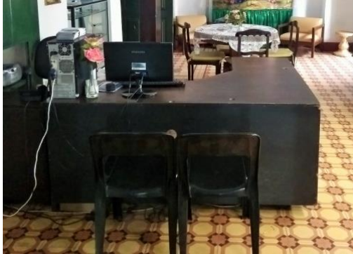
Figura 39- Piso em ladrilho hidráulico
