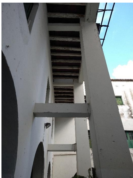
FOTO 105: Pilares e vigas de avanço sobre pátio |
