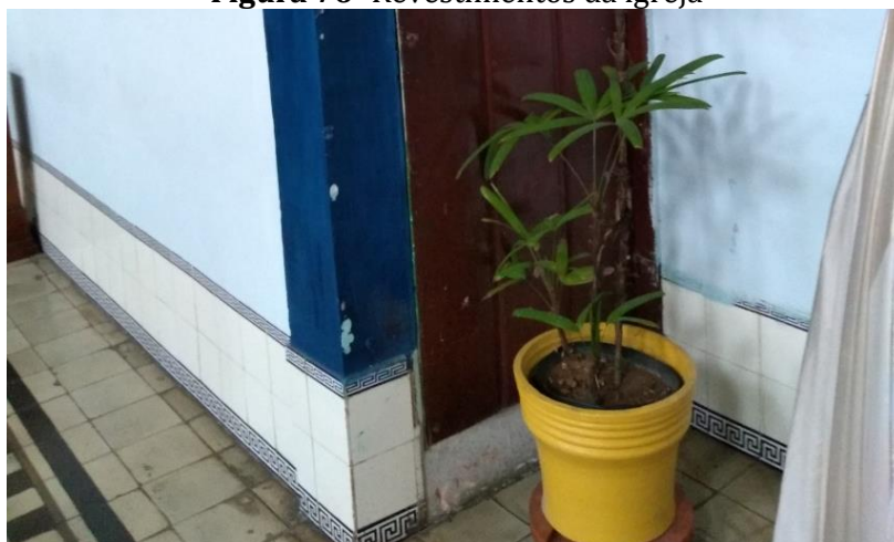
Figura 76- Revestimentos da igreja
