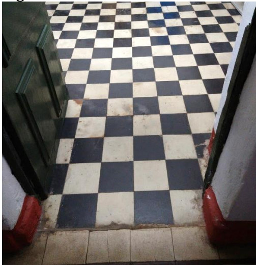
Figura 41- Piso em ladrilho hidráulico
