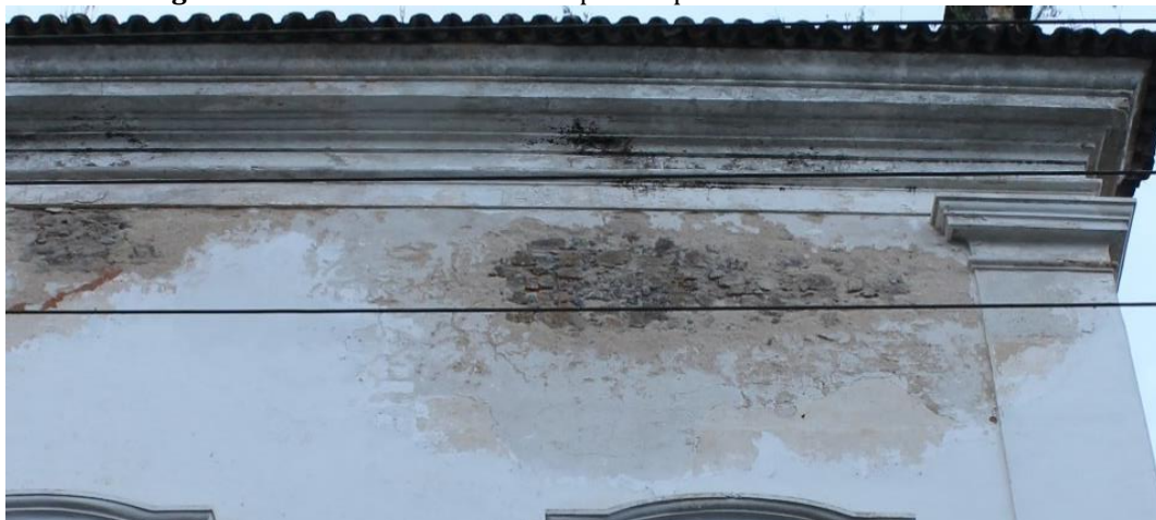
Figura 20- Trecho de alvenaria de pedra aparente na fachada noroeste
