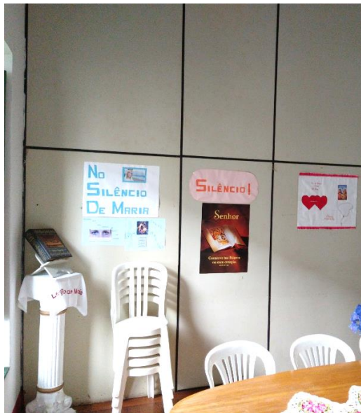
Figura 25- Divisória em pvc
