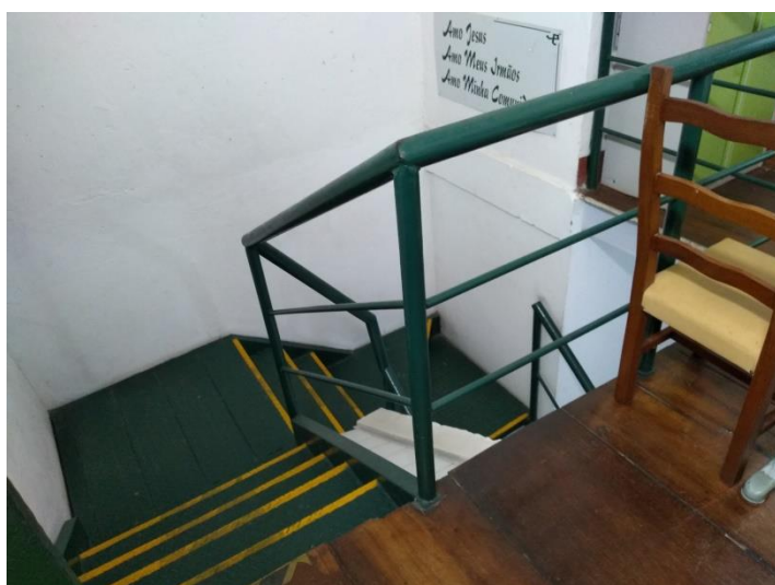
FOTO 95: Escada metálica do térreo do convento para o pátio do subsolo
