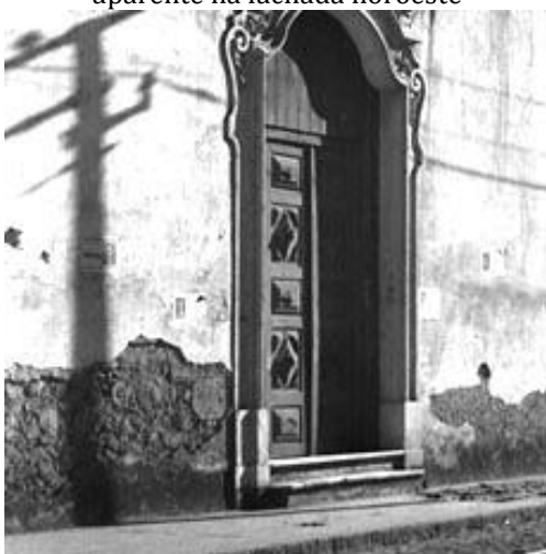
Figura 18- Trecho de alvenaria de pedra aparente na fachada noroeste
