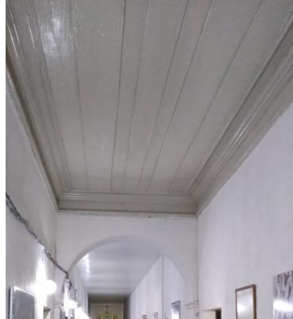
Figura 48- Forro em madeira tipo saia e camisa
