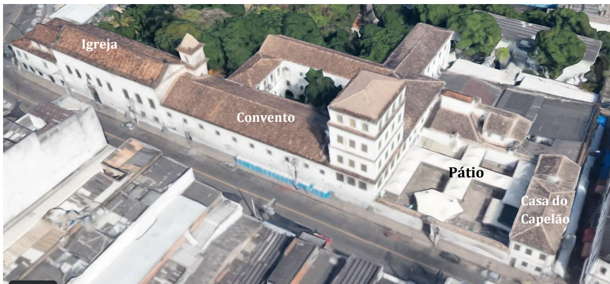
Figura 119- Fachada principal do conjunto e a relação de seus volumes construídos
