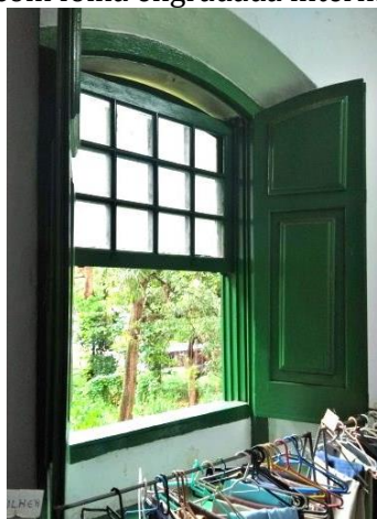
Figura 72- Folha de esquadria tipo guilhotina com folha engradada interna
