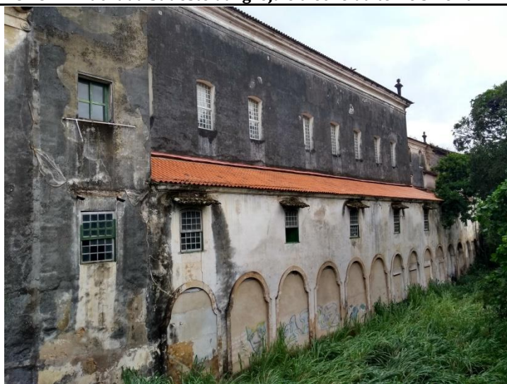
FOTO 41: Fachada Sudeste da igreja e trecho da torre sineira
