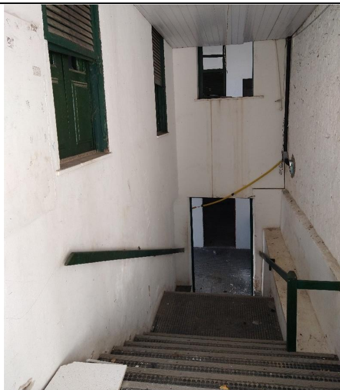
FOTO 100: Escada externa em concreto do pátio externo ao subsolo
