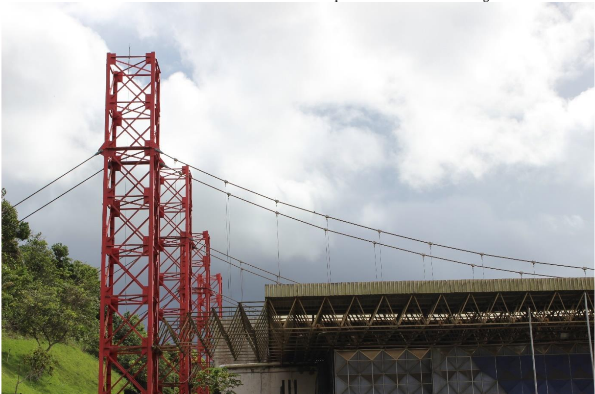
Foto 14 – Pilares Metálicos e catenárias de estruturação da cobertura. Foto: Rodrigo Sena.
