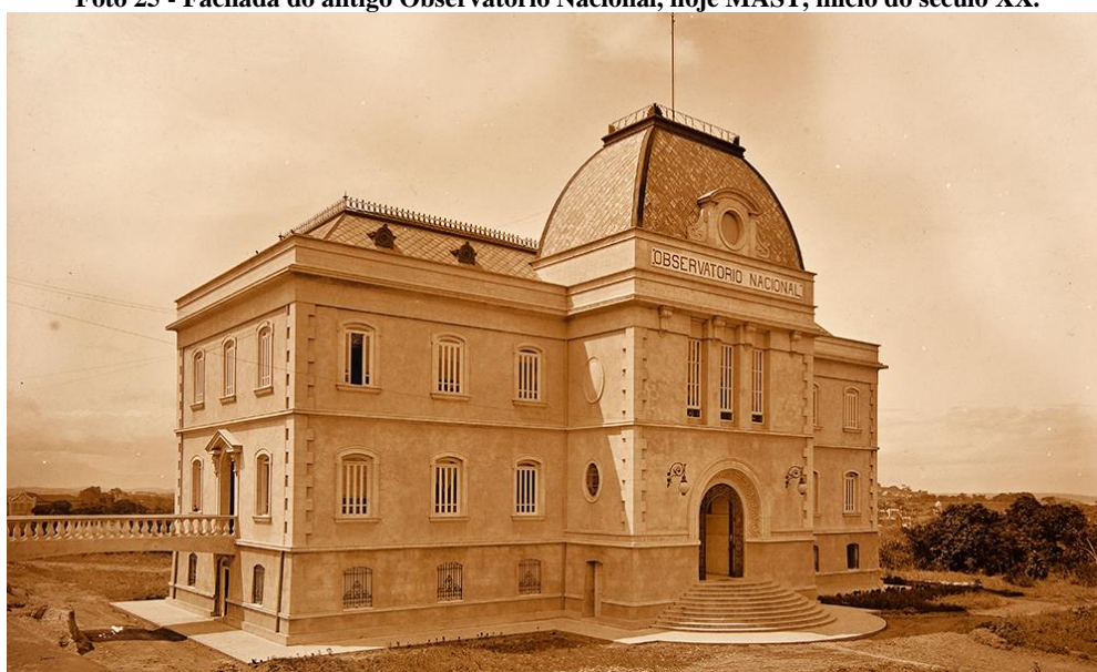
Foto 25 - Fachada do antigo Observatório Nacional, hoje MAST, início do século XX.
