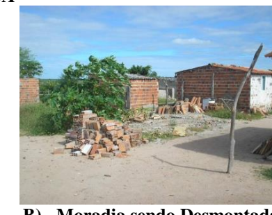
B) Moradia sendo Desmontada
