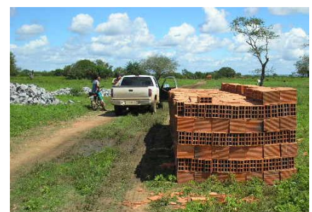
G) Material sendo colocado nos lotes
