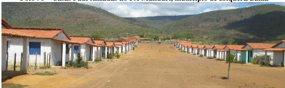
Foto 96 – Casas Padronizadas no PA Munduri, município de Ibiquera/Bahia
