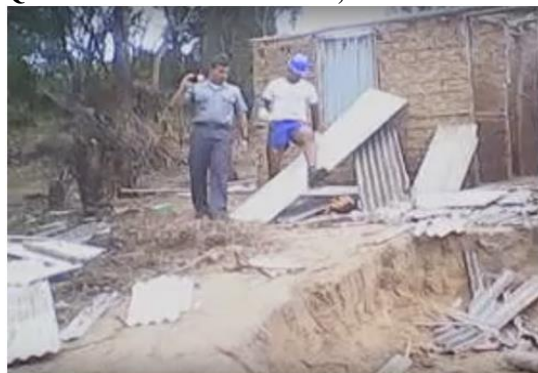
Foto 2 – Moradia Destruída na Comunidade Quilombola Rio dos Macacos, Simões Filho/BA
