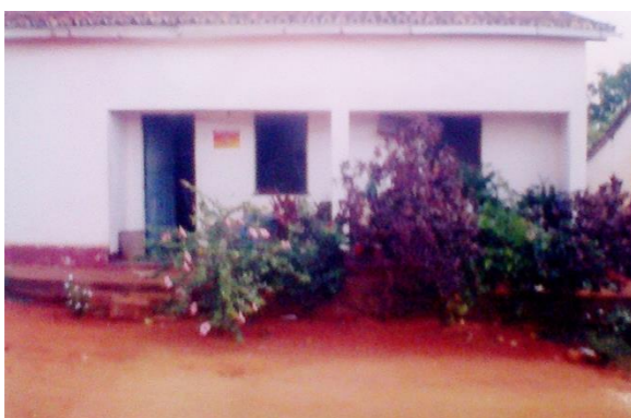
Foto 52 – Moradia de Administrador da Fazenda Reunidas Bandeira, Boa Vista do Tupim/BA
