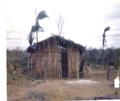
D) Moradia em Palha e Cobertura de Telha de Amianto e Lona
