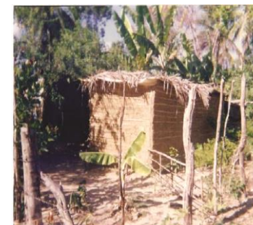
E) Moradia em Taipa e Cobertura em Palha
