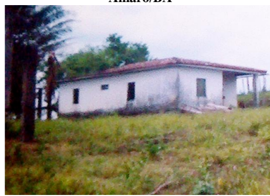
Foto 54 – Moradia de Administrador da Fazenda Nossa Senhora do Socorro, Santo Amaro/BA
