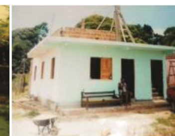
D) Moradia em Alvenaria com Laje
