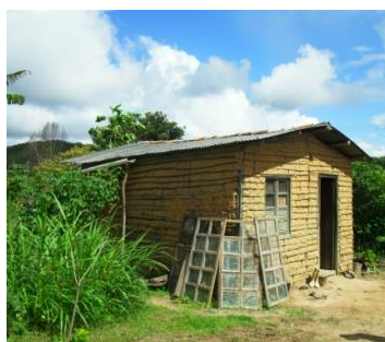
A) Moradia em Taipa com esquadrias
