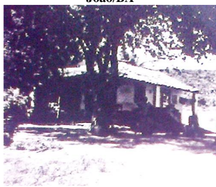
Foto 53 – Moradia de Administrador da Fazenda Santa Maria, Mata de São João/BA
