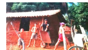
B) Escola em Construção (mutirão)
