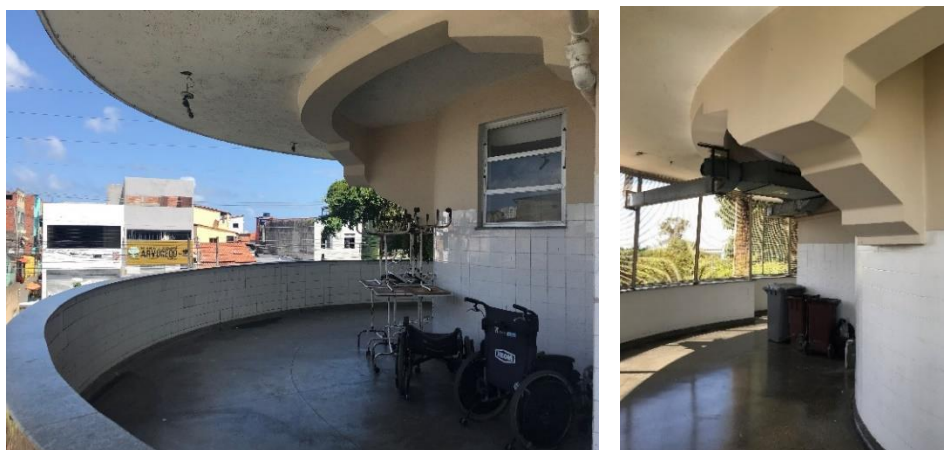
Figuras 181 e 182 – Viga curva de transição com elementos ornamentais escalonados na circulação da extremidade da Ala A, no 1º pavimento (à esquerda); detalhe da mísula de suporte da viga, que reflete a estética art déco , na circulação da extremidade da Ala B, no 1º pavimento (à direita).
