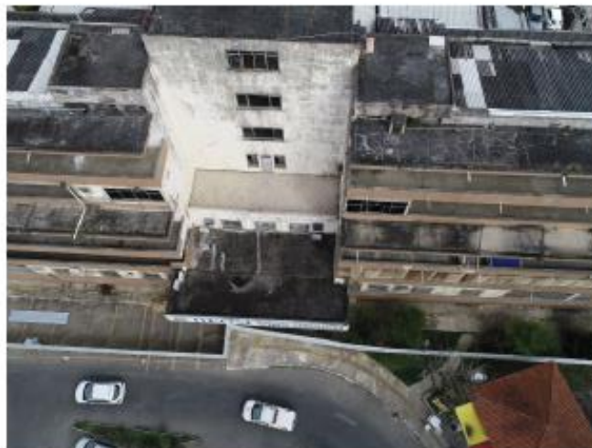
Voo drone realizado em 21/07/2021. A edificação e seu entorno urbano, em detalhes intervenções ocorridas no decorrer do tempo.
