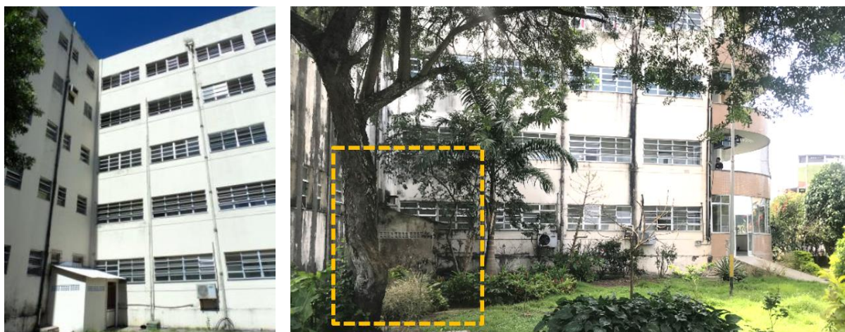
Figuras 292 e 293 – Acréscimo de um abrigo para compressor na fachada posterior do HEOM, em 2010 (à esquerda); abrigo para compressor, em meio à vegetação (à direita).
