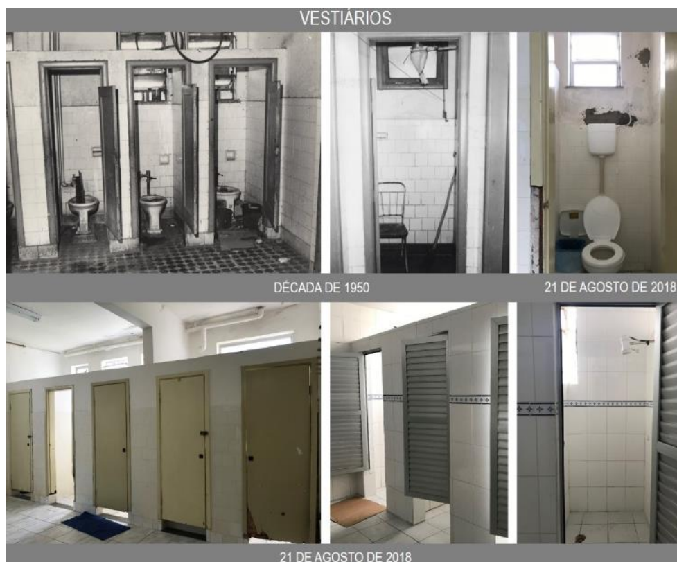
Figura 309 – Alterações nos vestiários: esquadrias, revestimentos e peças sanitárias.
