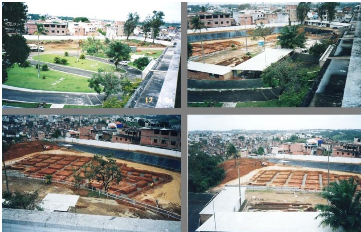
Figura 240 – Construção da maternidade a partir de 2004: o jardim em formato de pulmões visto desde os solários deu lugar à nova urbanização e à estrutura para se erguer o novo edifício.
