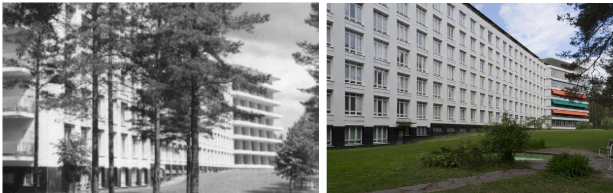
Figuras 102 e 103 – Vista da fachada sul no projeto original do Paimio (à esquerda); vista da fachada sul após intervenções, com toldos abertos nas varandas (à direita).
