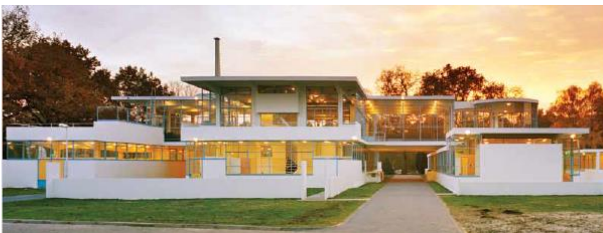
Figura 93 – Resultado da restauração no pavilhão principal do Sanatório Zonnestraal, após quatro décadas de pesquisa e planejamento da intervenção.
