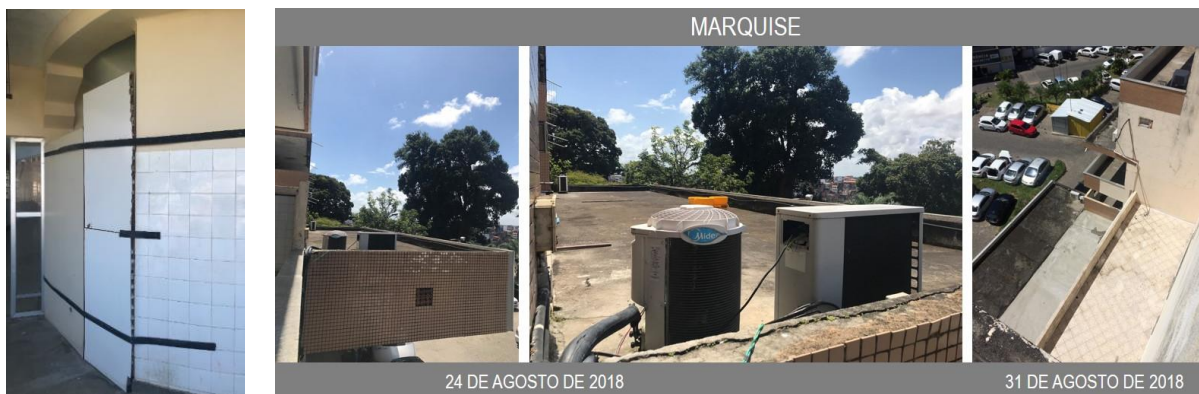
Figuras 320 e 321 – Fechamento da escada na extremidade curva das varandas (à esquerda); laje da marquise do HEOM: inserção de máquinas condensadoras de ar-condicionado (à direita).
