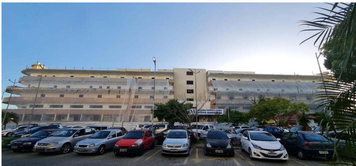
Figura 413 – Momento da obra em que se observa a retirada dos acréscimos e fechamentos das varandas, recuperando a horizontalidade da fachada principal.
