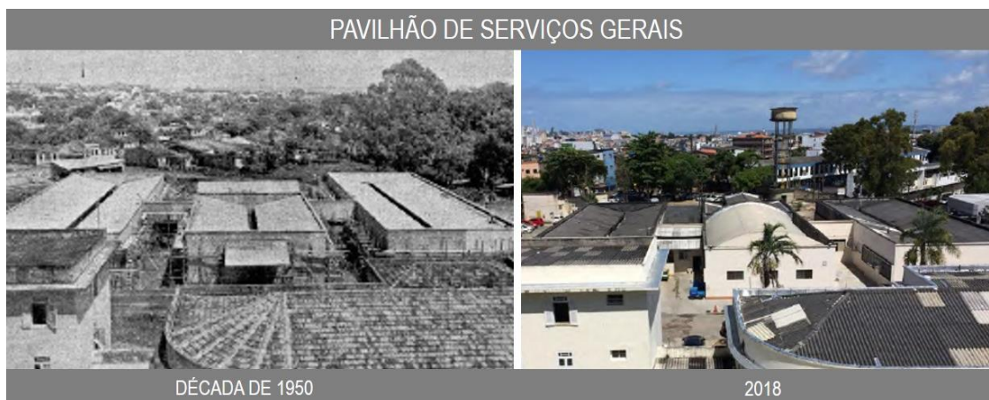
Figura 255 – Vista desde a cobertura do HEOM para o Pavilhão Hélio Fraga, à frente, e para o Pavilhão de Serviços Gerais, no segundo plano: modificação acentuada no entorno e na antiga cobertura borboleta do bloco central.
