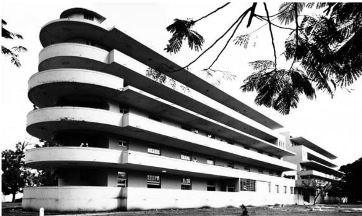
Figura 137 – Fachada principal do Hospital-Sanatório Santa Terezinha (sem data).
