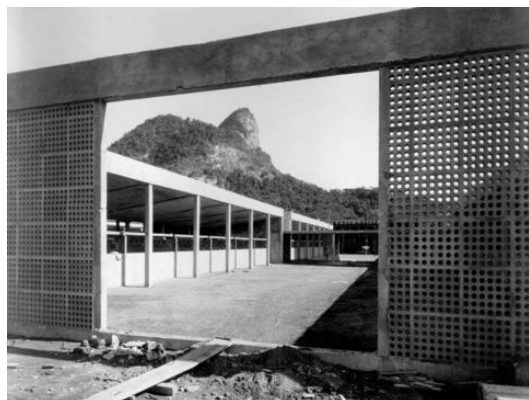
Figuras 129 e 130 – Sanatório de Curicica, de 1952, no Rio de Janeiro: modulação estrutural e elementos vazados circulares em estrutura pré-moldada, marcando o enquadramento da paisagem (à esquerda); Sanatório Azevedo Lima, em Niterói, no Rio de Janeiro, de 1939-1946, com capacidade para 350 leitos (à direita).
