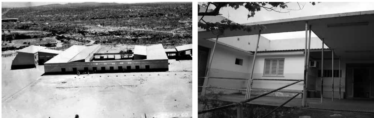
Figuras 123 e 124 – O Hospital Regional de Paulo Afonso, projetado em 1949 por Diógenes Rebouças (à esquerda); posto de saúde Almerinda Lomanto, inaugurado em 1951 (à direita).
