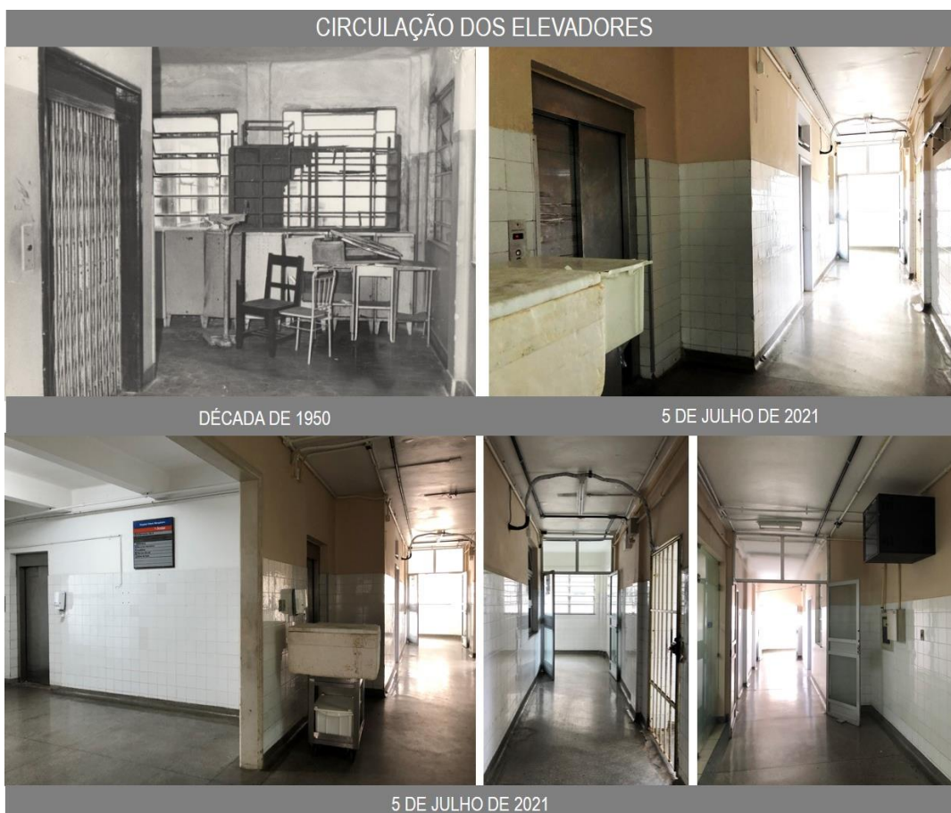
Figura 316 – Alterações na circulação dos elevadores: a) substituição dos elevadores; b) aplicação de azulejos brancos à meia altura, com pintura de cor acima; c) troca do piso hexagonal terracota por piso em granilite cinza; d) troca e/ou inserção de novas esquadrias; e) instalações e dutos aparentes.
