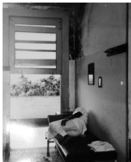
Figuras 203 e 204 – Modelos de esquadrias originais em madeira, vidro e ferro ainda existentes no hospital, em poucos ambientes (à esquerda); enfermaria do 3º ou 4º pavimento, com acesso à varanda através da esquadria de madeira do tipo guilhotina (à direita).
