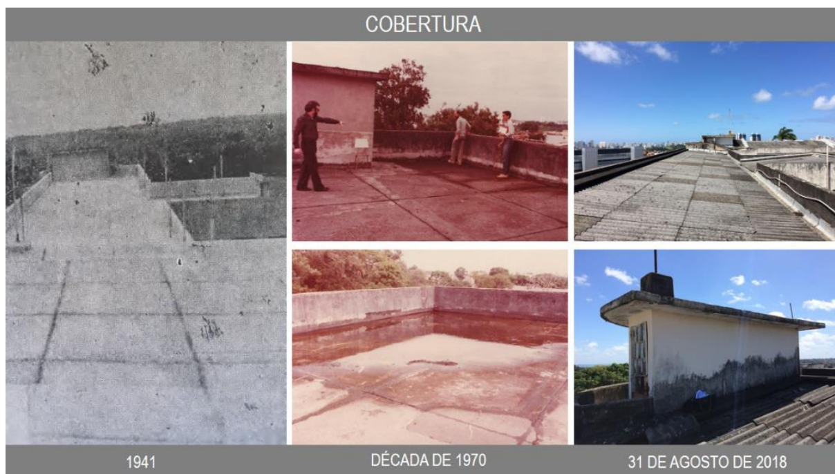
Figura 322 – Cobertura/terraço do HEOM: inicialmente, acessado pelos pacientes para a realização de helioterapia, hoje é coberto por telhas de fibrocimento.
