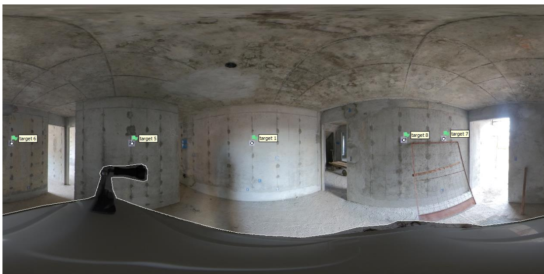
Figura 39 – Fotografia em formato equirretangular no Metashape com máscara aplicada na região do capacete e marcadores automaticamente identificados pelo software
