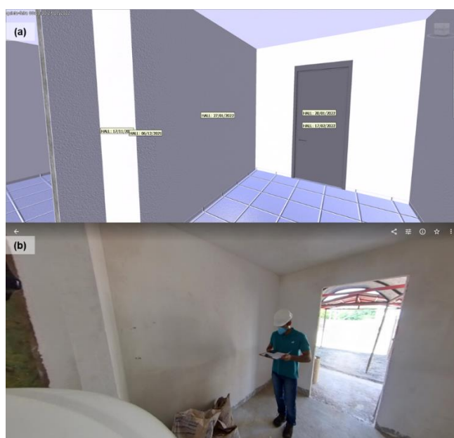
Figura 47 – (a) Hall de um dos edifícios da obra no modelo BIM 4D; (b) Fotografia 360° do mesmo local
