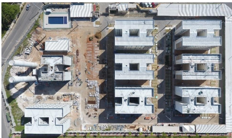
Figura 27 - Visão geral do canteiro (17/10/2019) – Estudo de caso C
