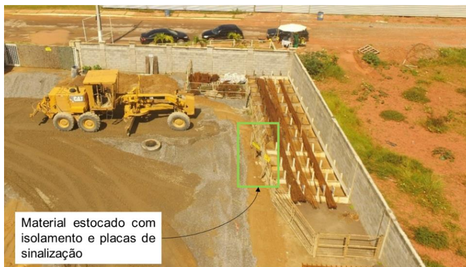
Figura 38 - Prática de isolamento e armazenamento do aço
