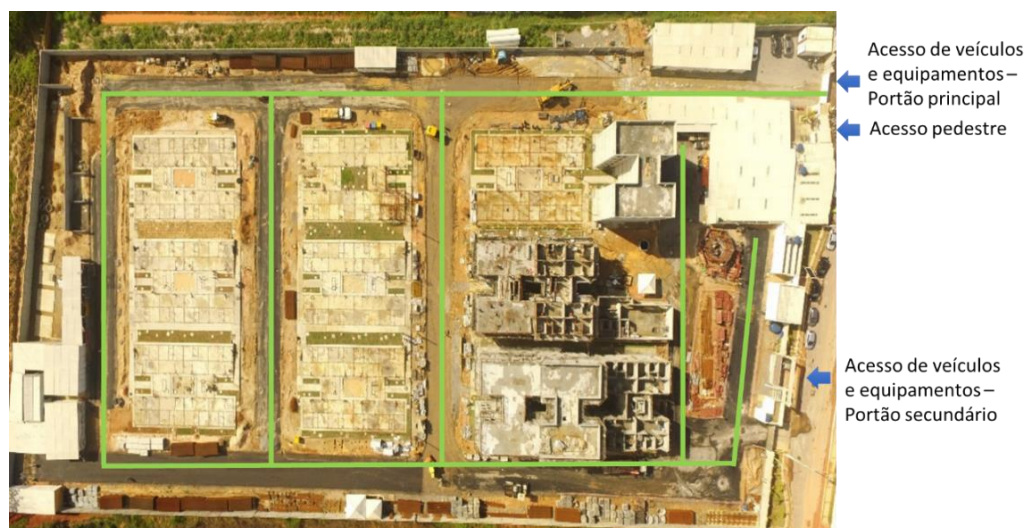
Figura 37 - Visão geral do canteiro - Logística e organização do canteiro
