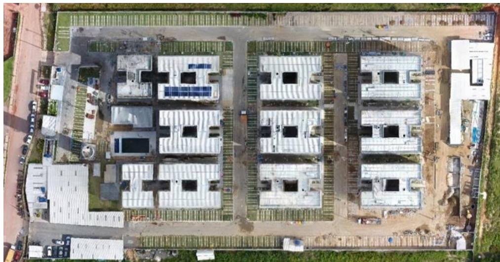
Figura 24 - Visão geral do canteiro (31/08/2018) – fase de acabamento
