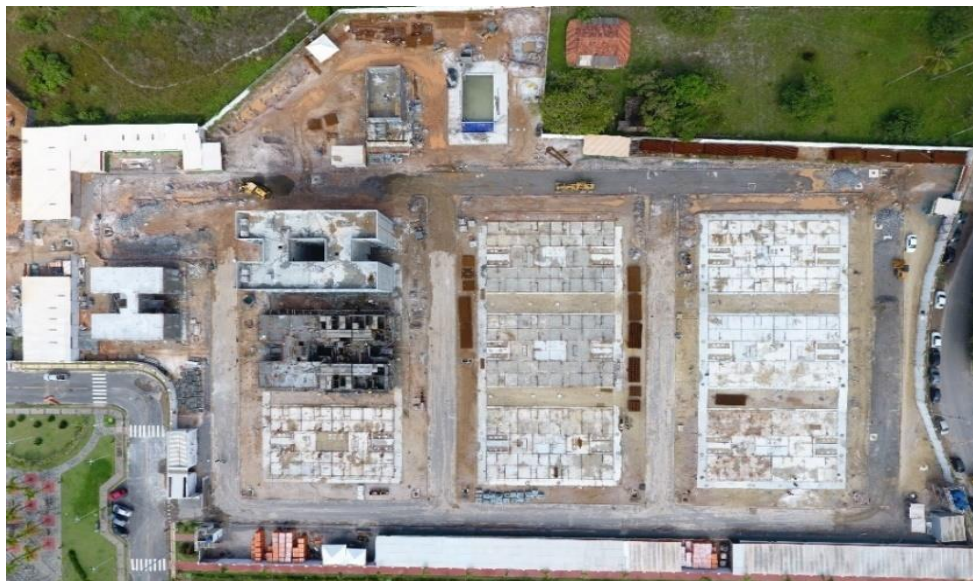
Figura 26 - Vista geral do canteiro (13/06/2019) – fase de estrutura
