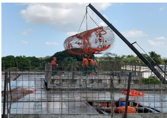
Figura 56 - Pré-montagem da armadura e instalação elétrica da laje
