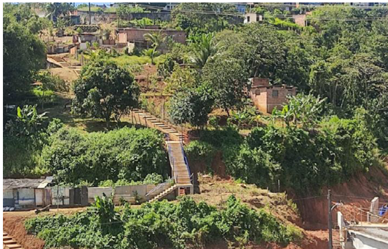
Figura 87: Construção da escada permanente onde estava a trilha-escada-parque, 2023
