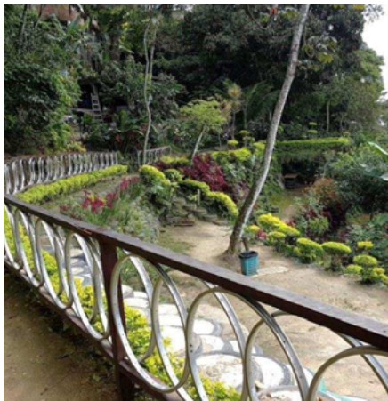
Figura 57: Trecho construído em pneus da trilha-escada-parque, 2019
