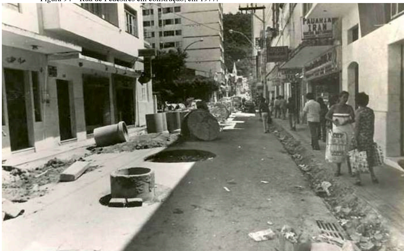
Figura 94 – Rua de Pedestres em construção, em 1977.
