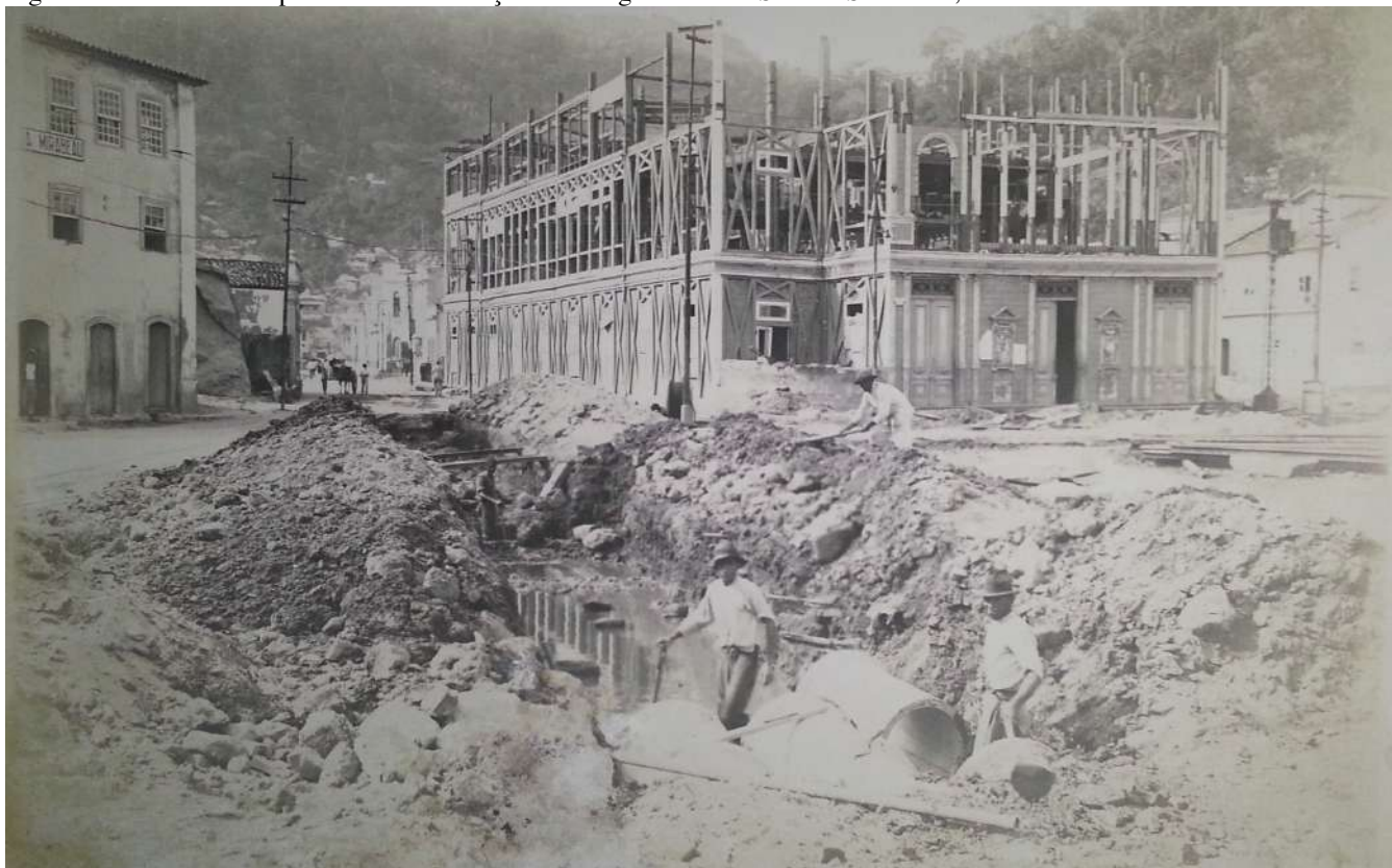
Figura 58 – Theatro Melpômene em demolição e drenagem da Rua Sete de Setembro, em 1924.
