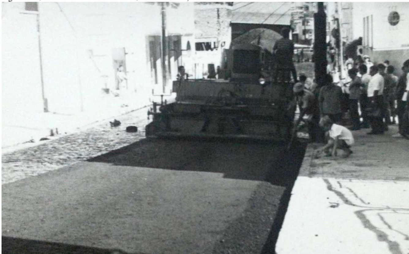
Figura 7 – Obra de asfaltamento da Rua Graciano Neves, década 1970.
