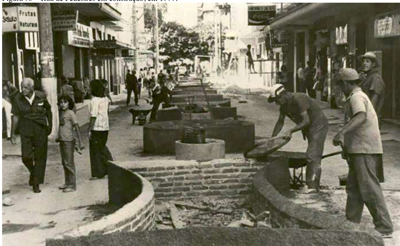
Figura 95 – Rua de Pedestres em construção, em 1977.
