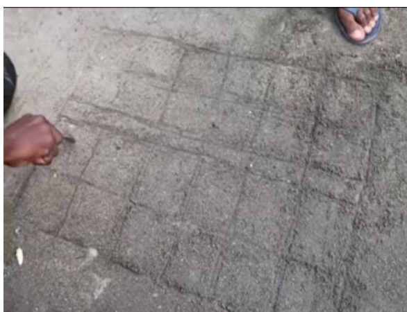
Figura 34: Marcação das medições para construção
