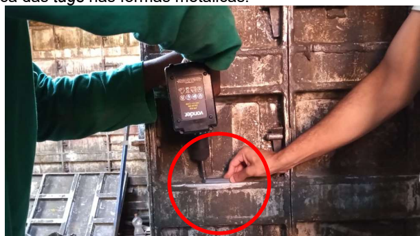
Figura 63 - Fixação mecânica das tags nas formas metálicas.
