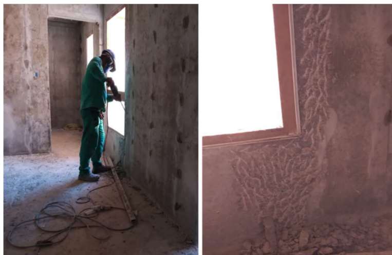
Figura 74 - Serviço de tratamento interno, retrabalho para regularização.
