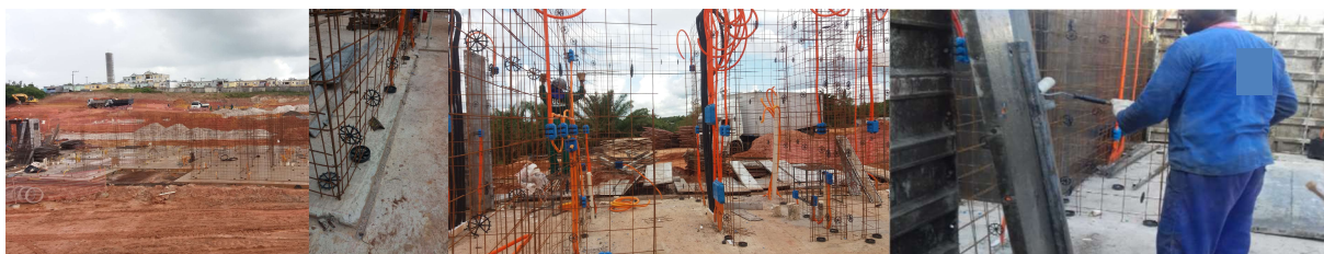
(16) Armagem das paredes
