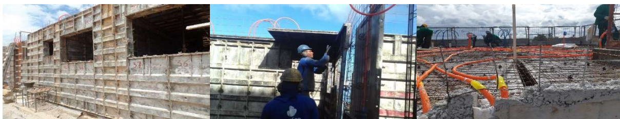
(19) Montagem das formas da parede
