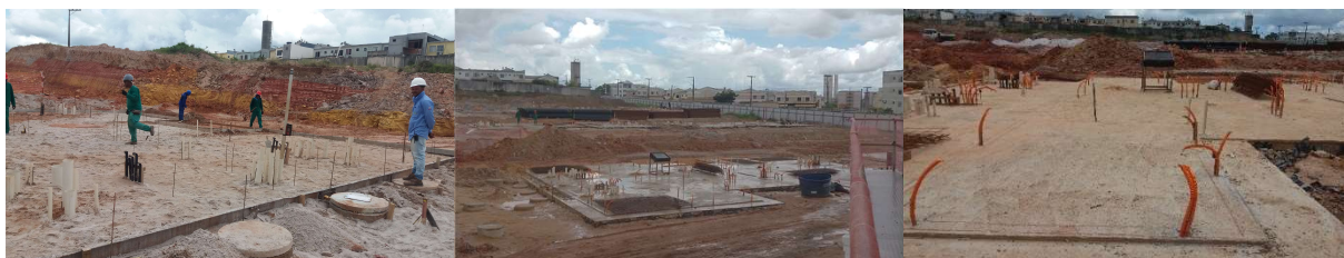
(13) Fixação das instalações
