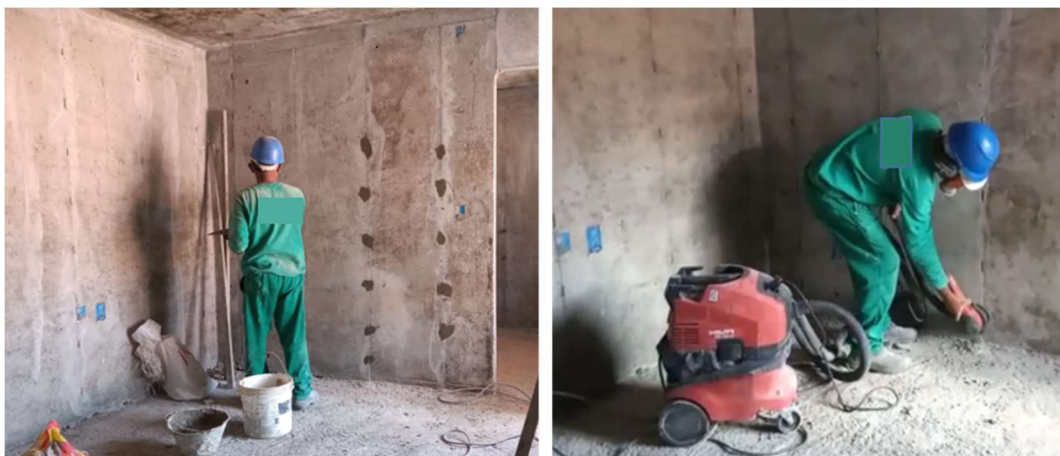
Figura 73 - Serviço de tratamento interno, com fechamento das aberturas deixadas pelas faquetas e lixamento.
