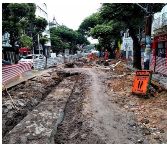
Foto 1 Obras Avenida Sete 2019
