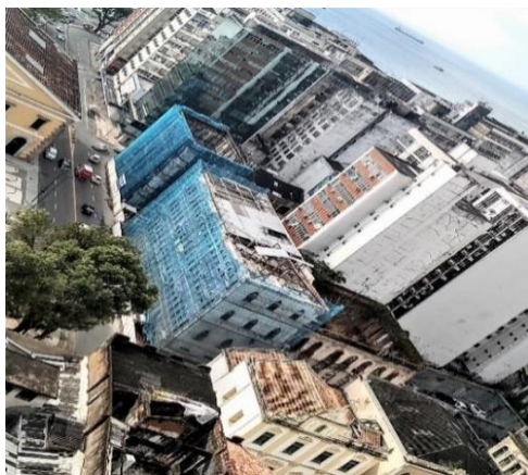
Foto 9. Intervenções nos prédios antigos para a construção casa da história e arquivo Municipal. Foto tirada em 2020 (antes da Pandemia)
