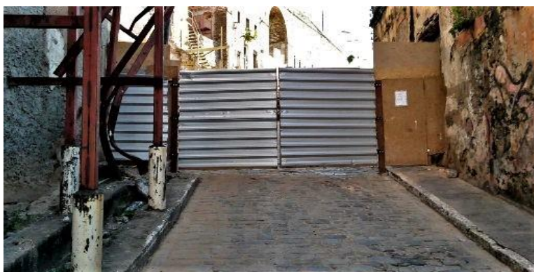
Foto 11. Ladeira da Conceição foi fechada por conta das obras de renovação que se desenvolviam em 2019. Foto tirada em novembro 2019 pelo autor
