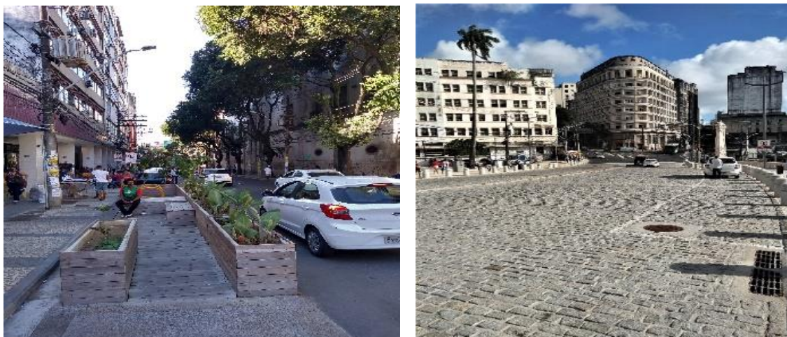
Fotos 3 e 4. Obras entregues para facilitar o acesso e a organização do espaço público. Fotos tiradas em 2020
