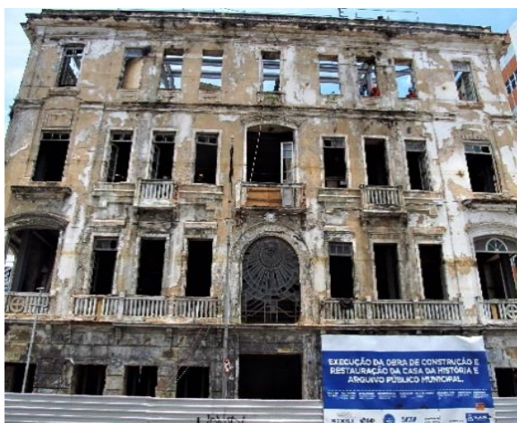
Foto 13. Avisos que anunciam futuras obras e empreendimentos. Foto tirada no Comercio, frente ao Mercado Modelo. Futura Casa da História e Arquivo Público. 2021
