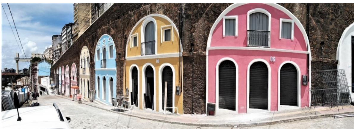
Foto 12. Ladeira da Conceição. Obra terminada. Foto tirada em janeiro 2021.
