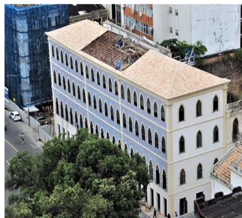
Foto 10. Foto tirado em 2021. Obra em processo de finalização. Museu da História de Salvador
