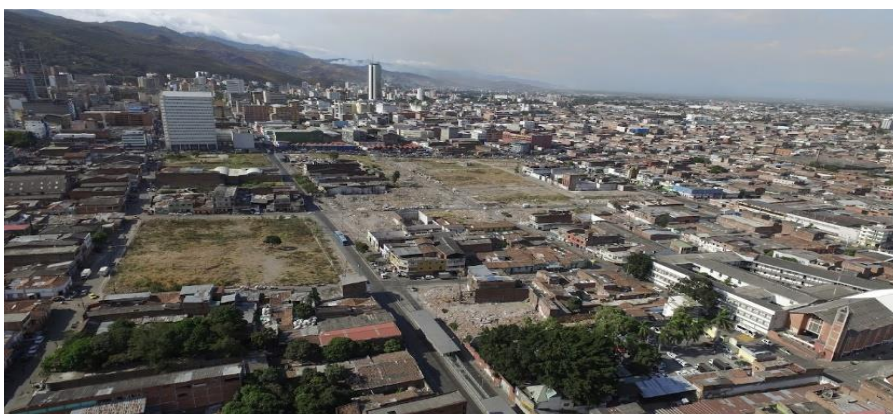
Foto 33. Terreno demolido e pronto para a construção de Cidade Paraíso. Fonte EMRU 2021
