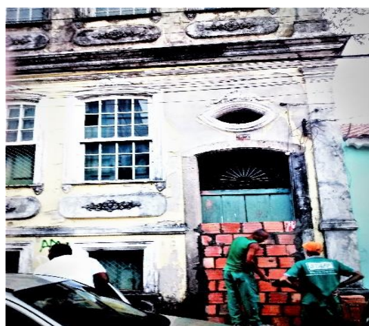
Foto 14. Casarões fechados no CHS. Foto tirada pelo autor 2019
