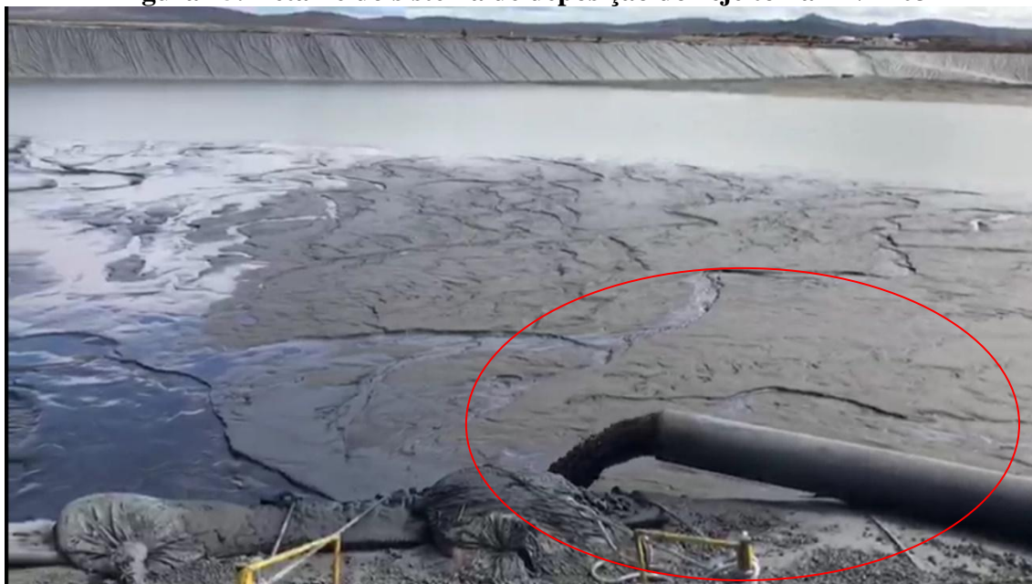
Figura 15. Detalhe do sistema de deposição do rejeito na BNM-03
