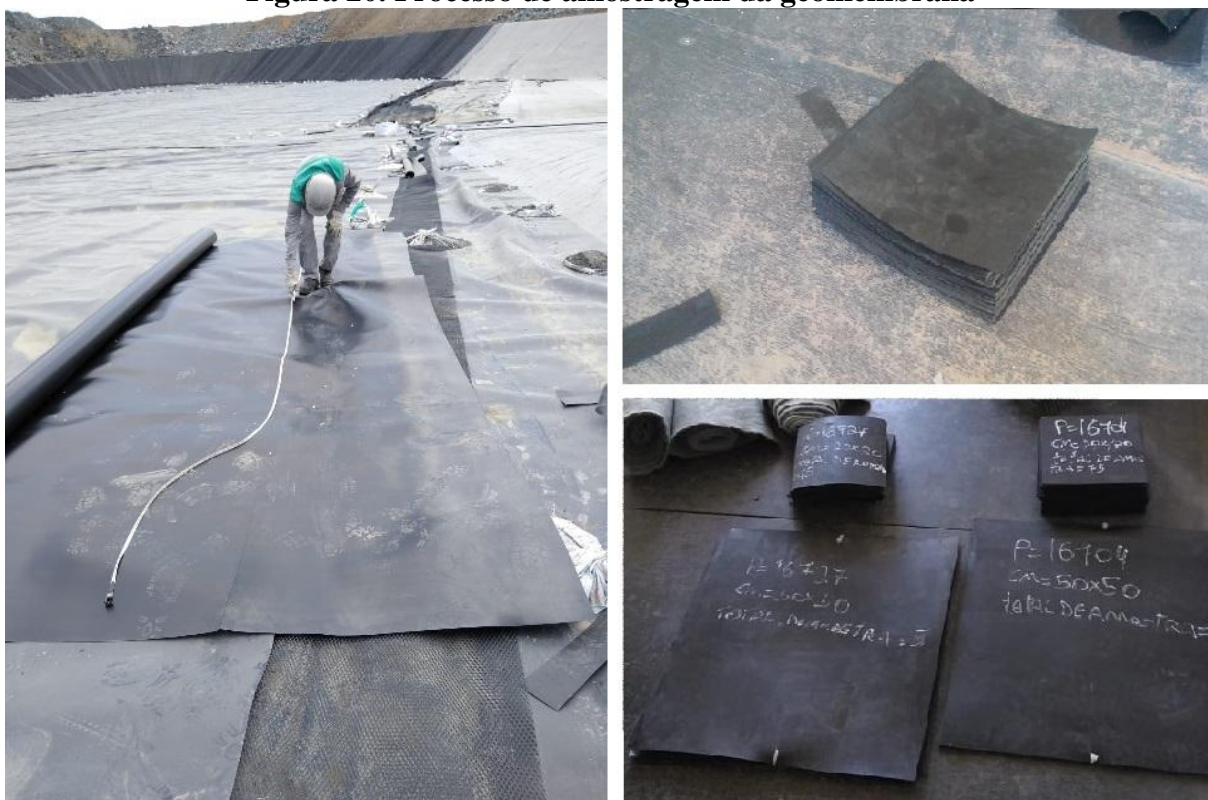
Figura 20. Processo de amostragem da geomembrana
