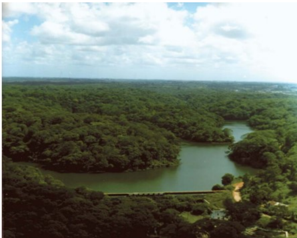
Figura 1 – Vista aérea da Barragem do Cobre
