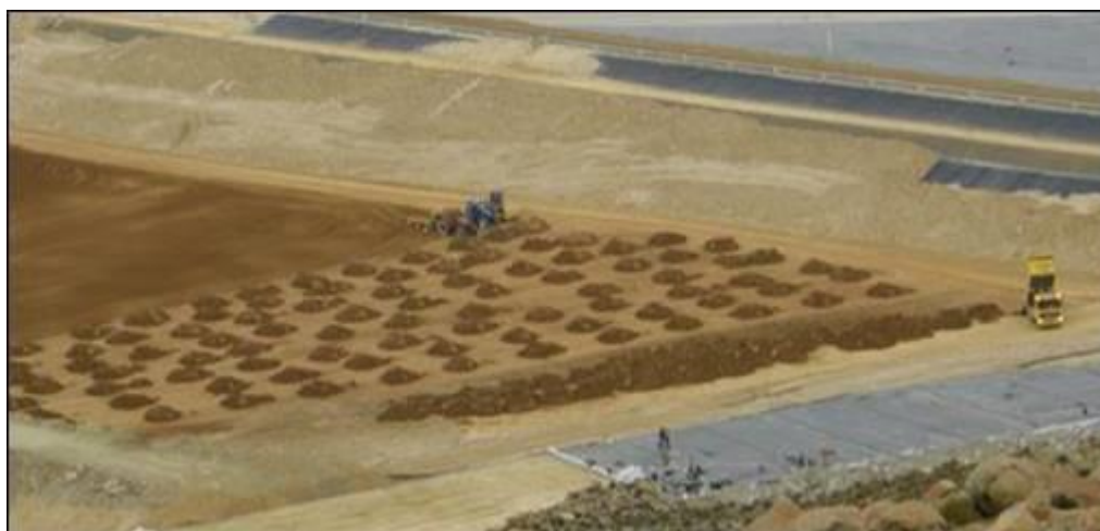
Figura 5 – Método de disposição utilizando a técnica do empilhamento a seco.
