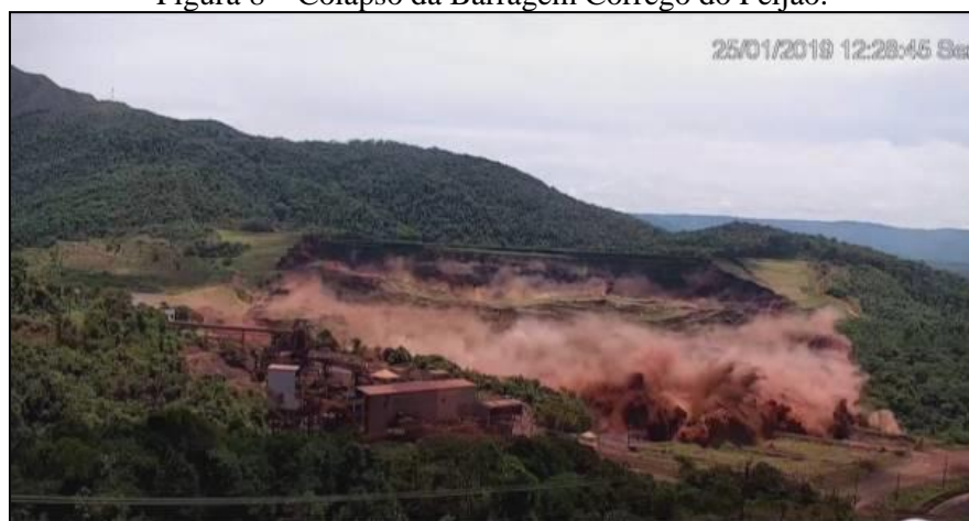
Figura 8 – Colapso da Barragem Córrego do Feijão.
