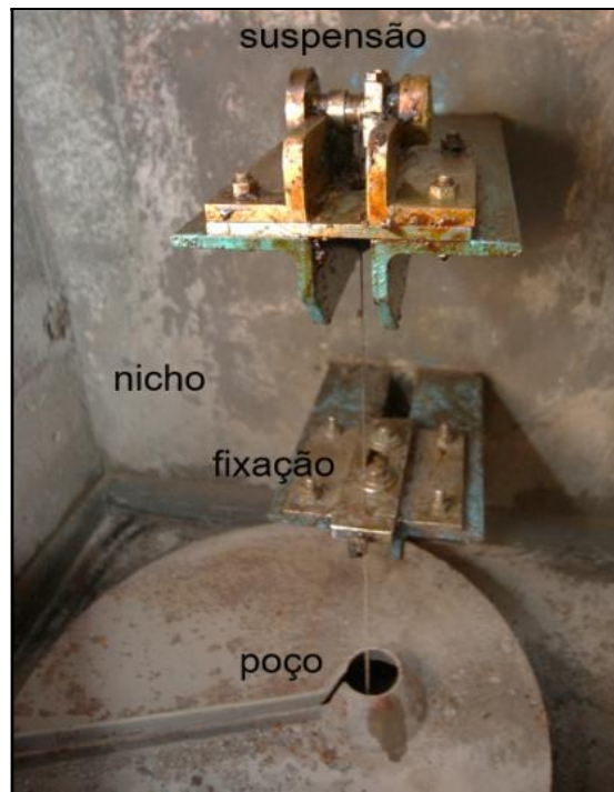
Figura 7 – Nicho de fixação do Pêndulo Direto na crista da barragem.
