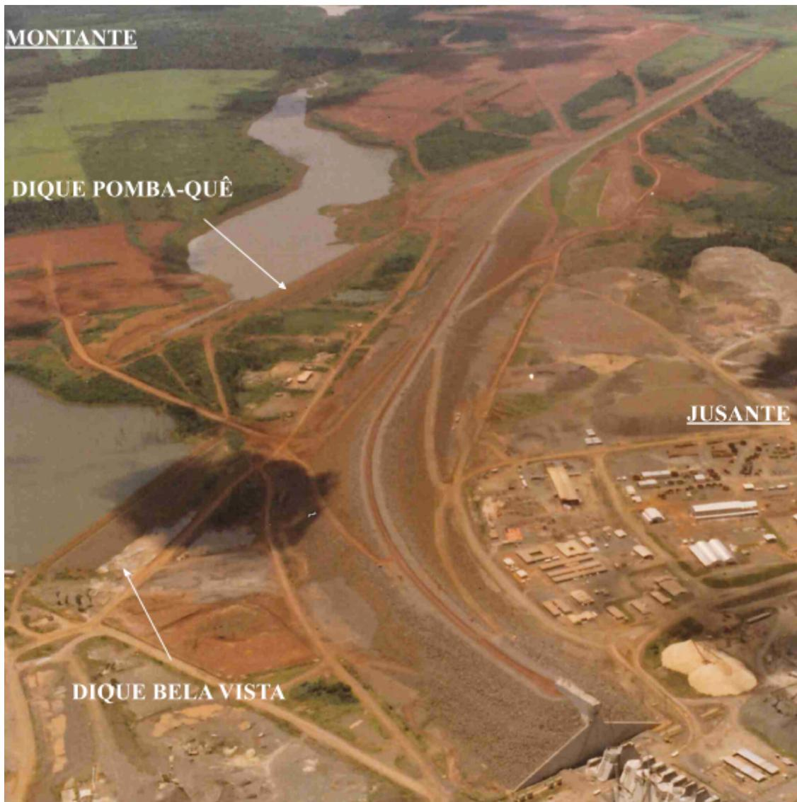
Figura 3-2 - Diques Bela Vista e Pomba-Quê durante construção da barragem (Fonte: Arquivo fotográfico – Itaipu).
