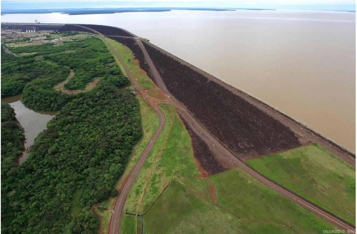
Figura 3-1 - Vista geral da barragem de enrocamento (Fonte: Arquivo fotográfico – Itaipu).
