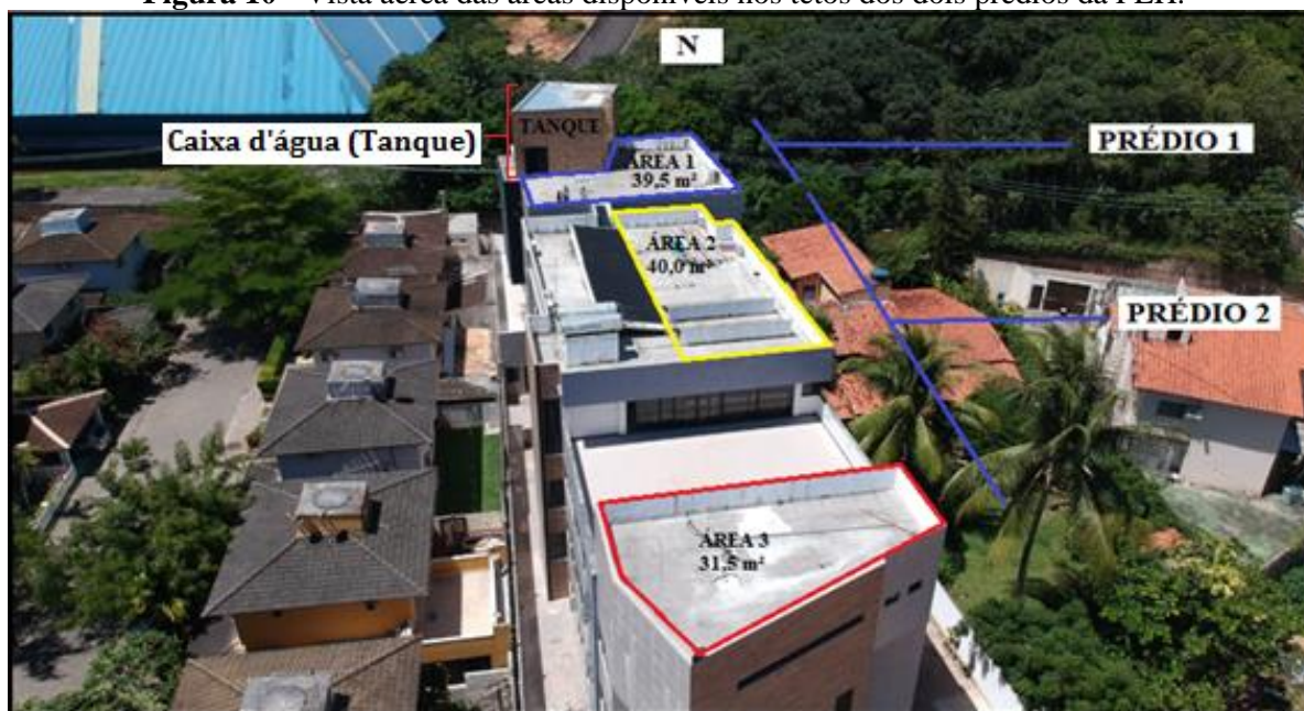
Figura 10 - Vista aérea das áreas disponíveis nos tetos dos dois prédios da FLH.
