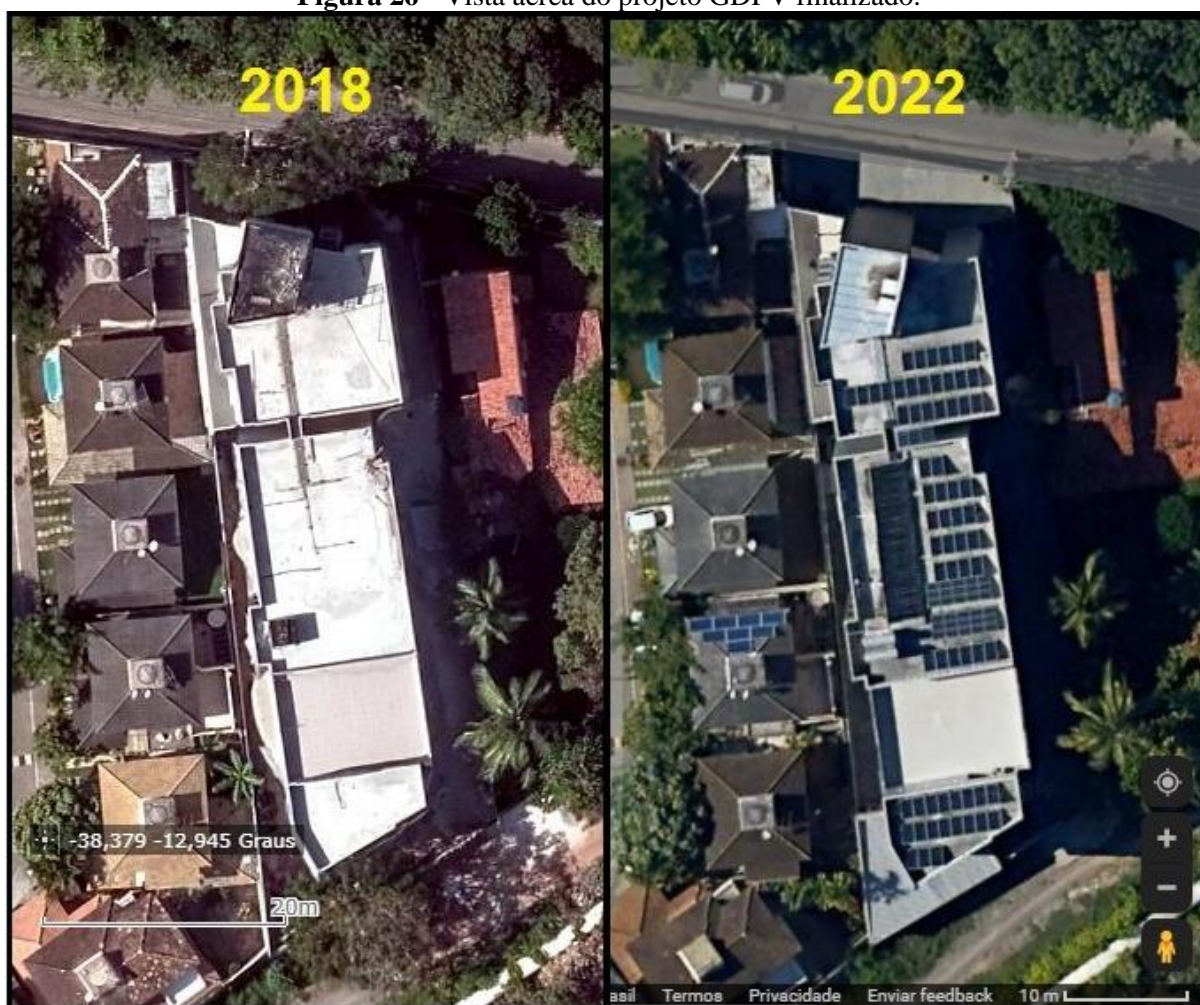
Figura 26 - Vista aérea do projeto GDFV finalizado.
