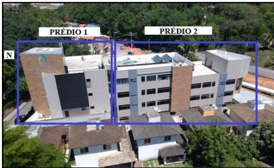
Figura 9 - Vista da Fachada Lateral do Prédio do Lar para Idosos FLH
