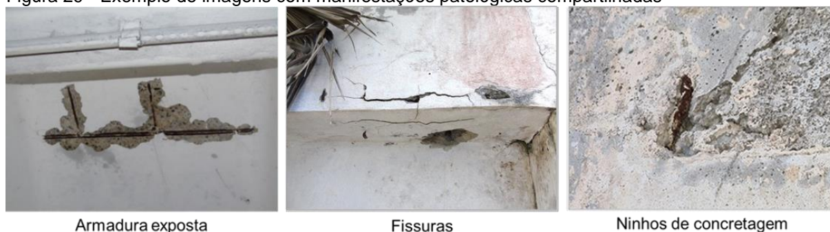
Figura 29 - Exemplo de imagens com manifestações patológicas compartilhadas
