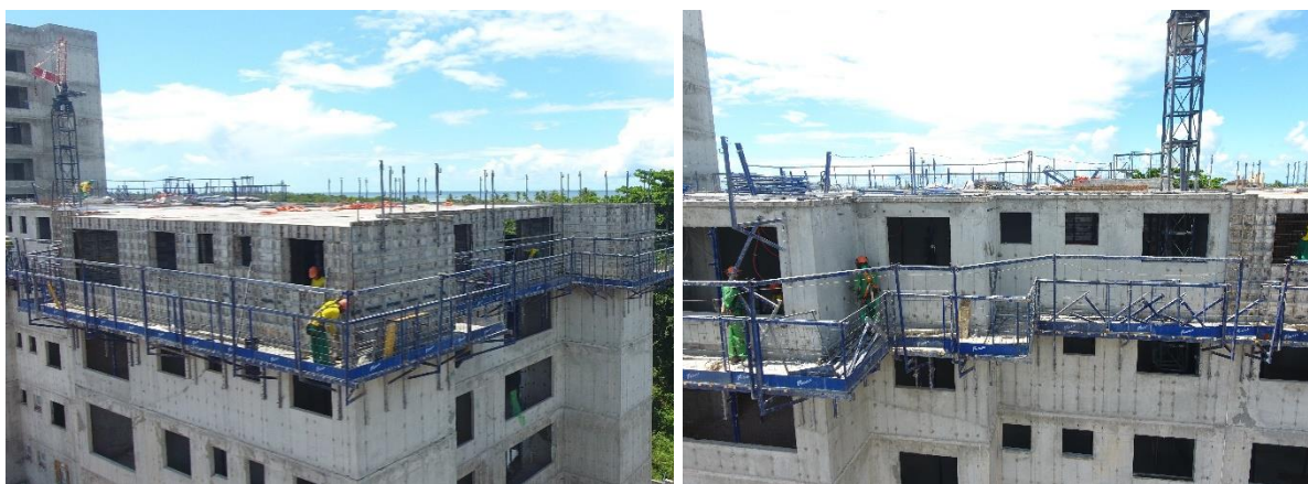
Figura 43 - Desforma após a concretagem
