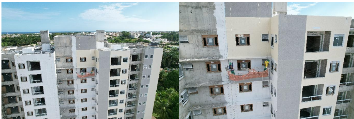
Figura 44 - Tratamento de fachada
