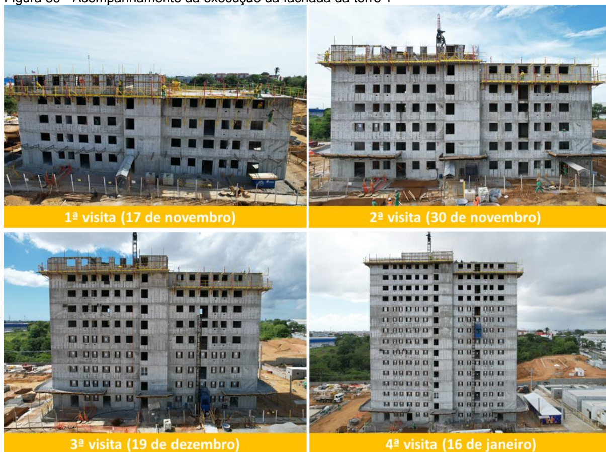
Figura 59 - Acompanhamento da execução da fachada da torre 1
