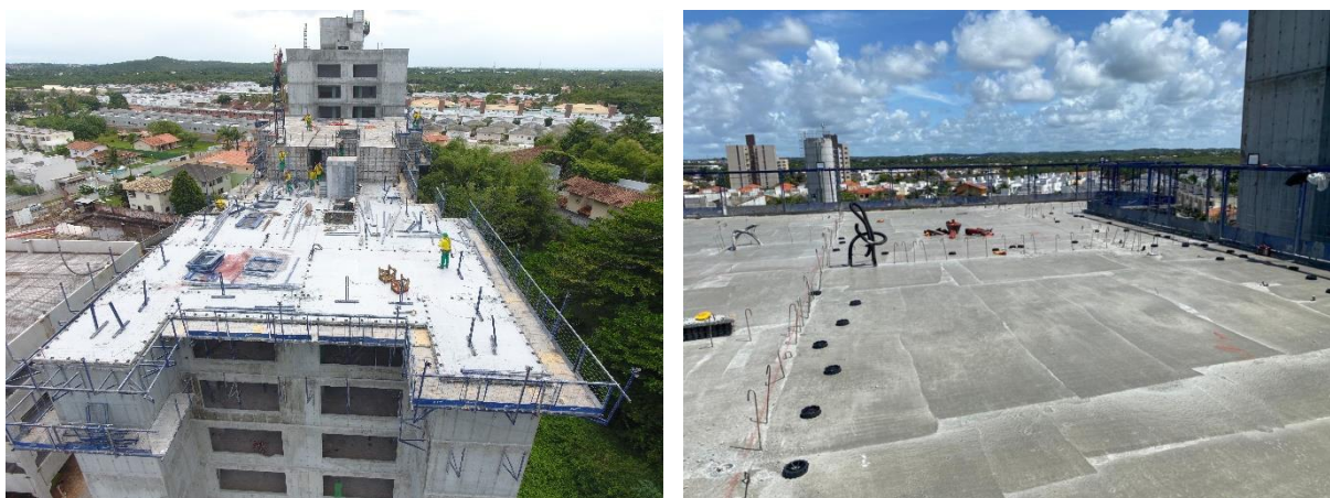
Figura 39 - Marcação das linhas auxiliares para montagem das formas de paredes
