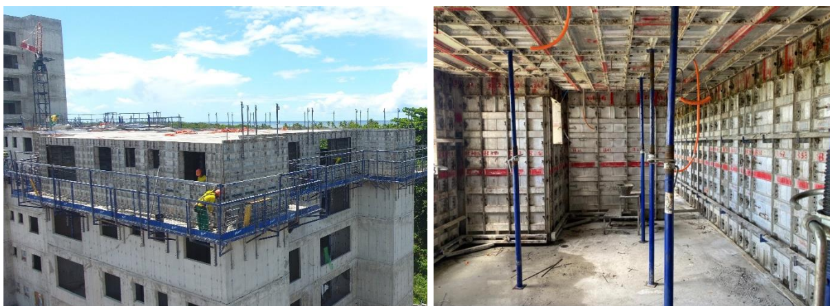
Figura 41 - Montagem das Formas
