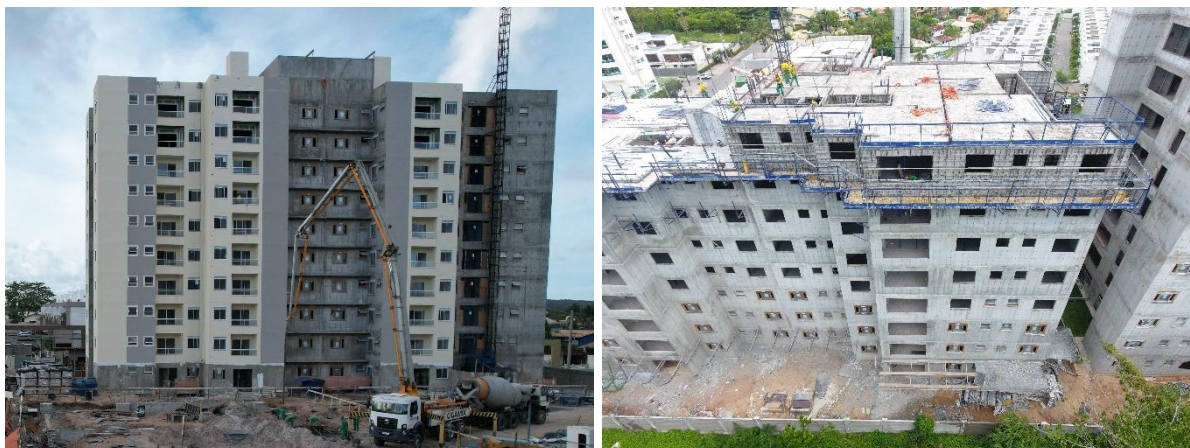
Figura 42 - Concretagem das paredes
