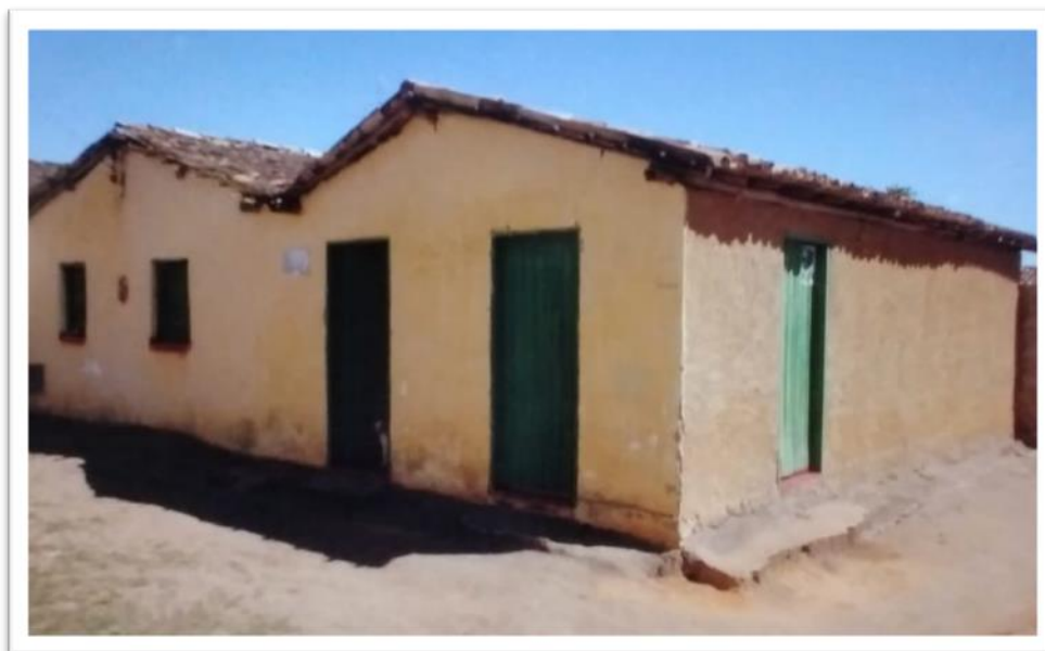
Imagem 3 – Nossa casa-passagem na zona urbana 15
