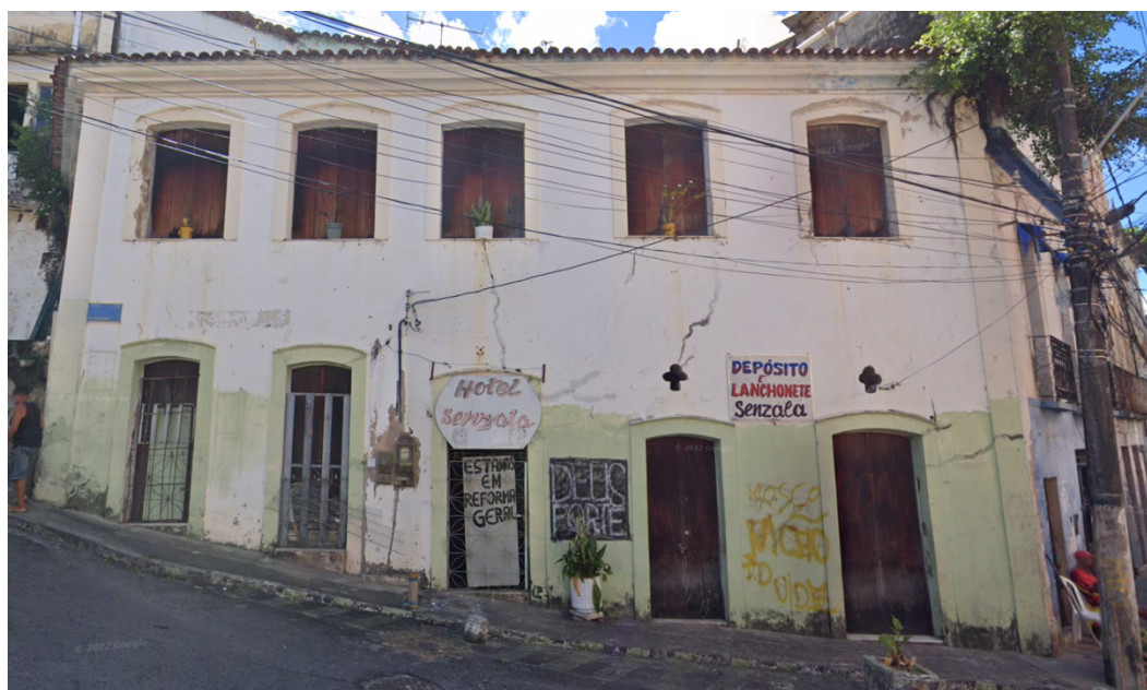
Imagem 28 – Imóvel localizado na Rua do Gravatá, em Salvador. Fonte: Google Maps
