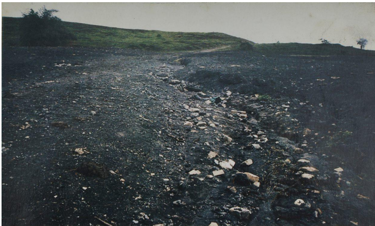
Foto 6-4. Erosão desenvolvida pelas águas superficiais no centro do barramento da escória carreando material particulado em direção ao rio Subaé.
