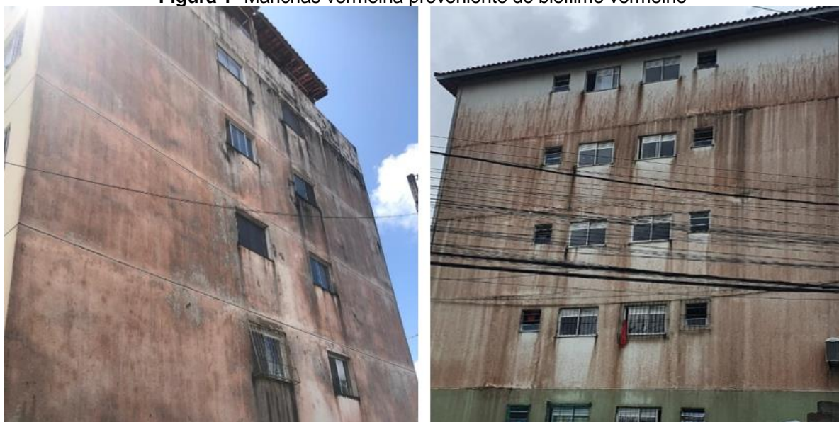
Figura 1- Manchas vermelha proveniente do biofilme vermelho
