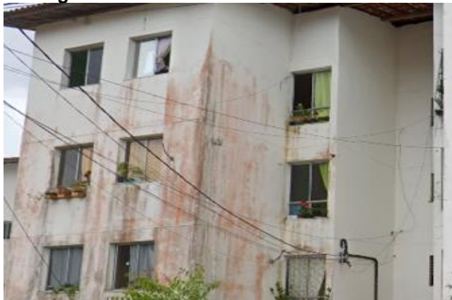
Figura 10 - Biofilme vermelho em fachada - Brasil
