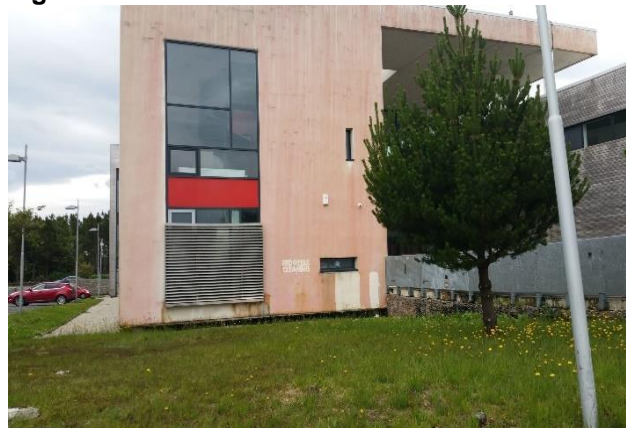
Figura 11 - Biofilme vermelho em fachada - Irlanda
