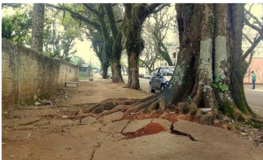
Figura 6 – Destruição de calçadas pelas raízes de árvore
