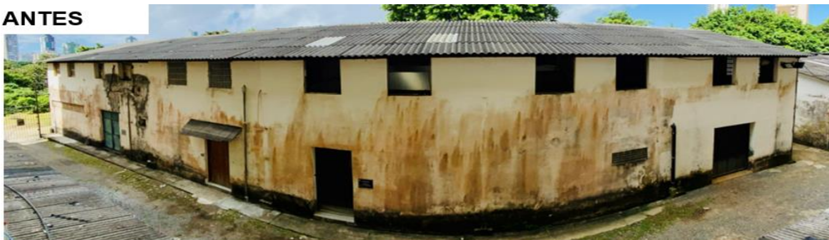
Figura 32 - Antes e depois da lavagem da fachada com o sabão Yellow Pine
