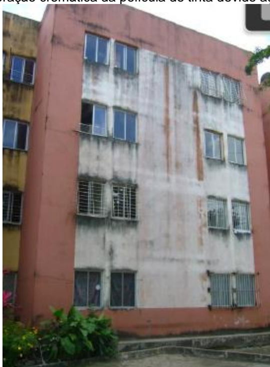
Figura 5 - Alteração cromática da película de tinta devido ação da radiação
