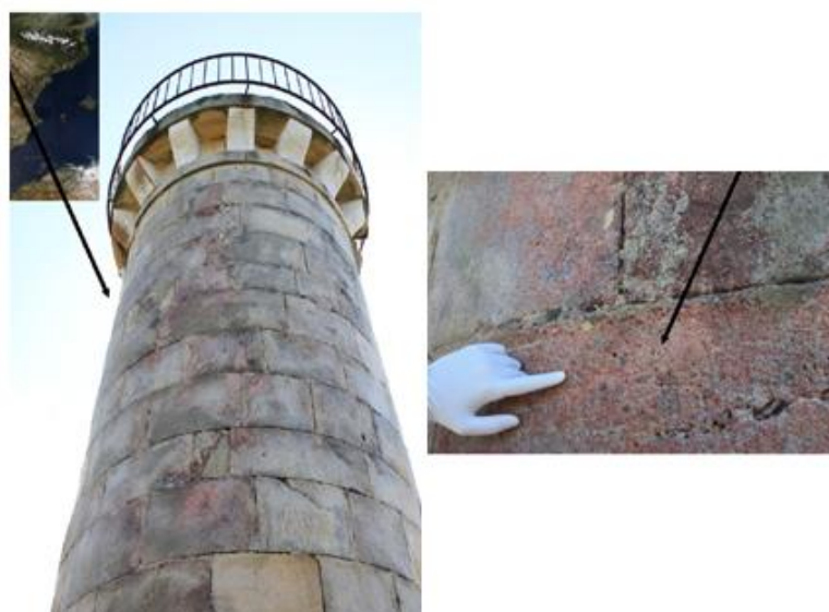
Figura 12 - Biofilme vermelho colonizando o arenito da torre
