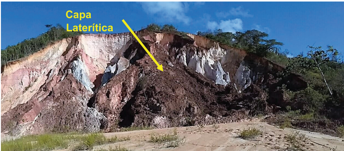
Fig. 10.7: Vista da voçoroca com destaque para capa laterítica.
