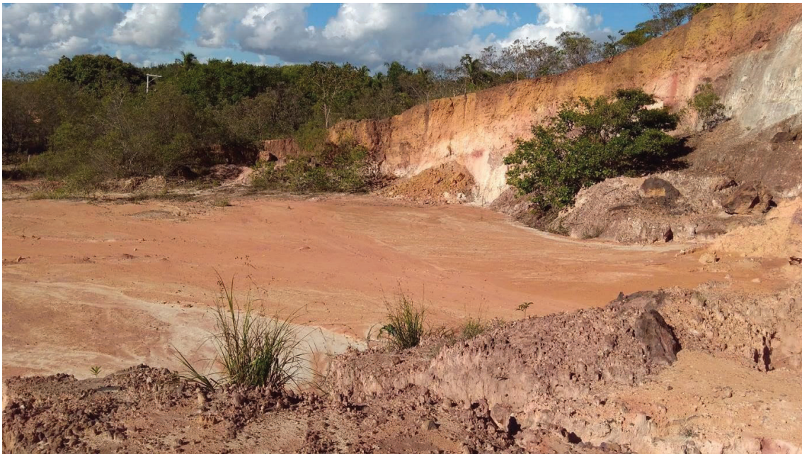
Fig. 10.4: Vista da planície de espreadimento dos sedimentos.
