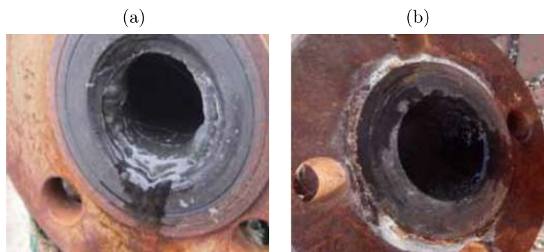
Figura 2.14: Oleoduto: (a) sem o tratamento com campo magnético e (b) após a inserção do dispositivo magnético
