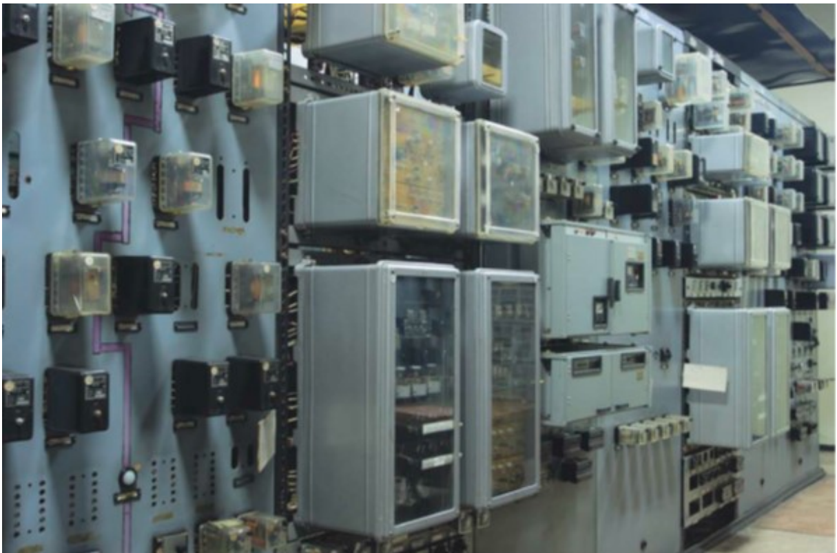
Figura 1 – Típico painel de relés na década de 1960
