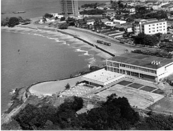
Figura 24: Imagem aérea do Clube Libanês do Espírito Santo, sendo visível o bloco superior longitudinal, o terraço lateral e as plataformas do clube em diferentes alturas. Fonte: Arquivo Memória Capixaba, Fábio Pirajá, sem data.
