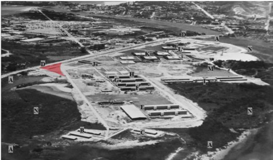
Figura 7 - Vista aérea parcial do Campus Universitário Alao de Queiroz Araújo – sentido norte/sul (A), com os prédios construídos até meados da década de 1970, com destaque para os aterros realizados. B - Departamento de Administração/Prefeitura Universitária; C - Gráfica Universitária; D - Avenida Fernando Ferrari; E - Centro Tecnológico (CT's I e II/ITUFES); F - Centro de Educação (IC IV); G- Centro de Ciências Humanas e Naturais (IC's II e III); H - Centro de Ciências Exatas (IC I); I - Centro de Ciências Jurídicas e Econômicas (ED's I, II, III, IV e Administração); J - CWF; K - Centro de Artes (CEMUNI's I, II, III, IV, V e VI); L - Centro de Educação Física e Desportos; M - Lagoa e N - Manguezal de entorno. Fonte: Biblioteca Central da UFES/Seção de Coleções Especiais.
