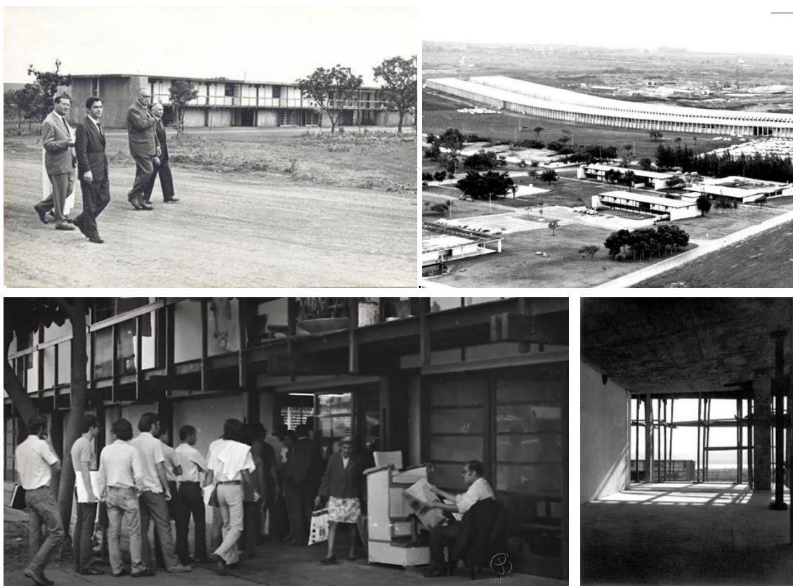
Figura 379, 380, 381 e 382: Fotografias dos edifícios Oca 1 e Oca 2 no campus da UnB, construídos com base no sistema SR2 de Rodrigues.
