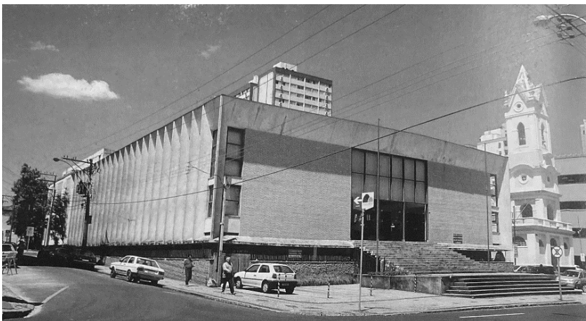
Figura 325: Fórum de Piracicaba (1962), de Affonso Eduardo Reidy, com destaque para as fachadas laterais marcadas pelos brises verticais. Fonte: BONDUKI, 1999.
