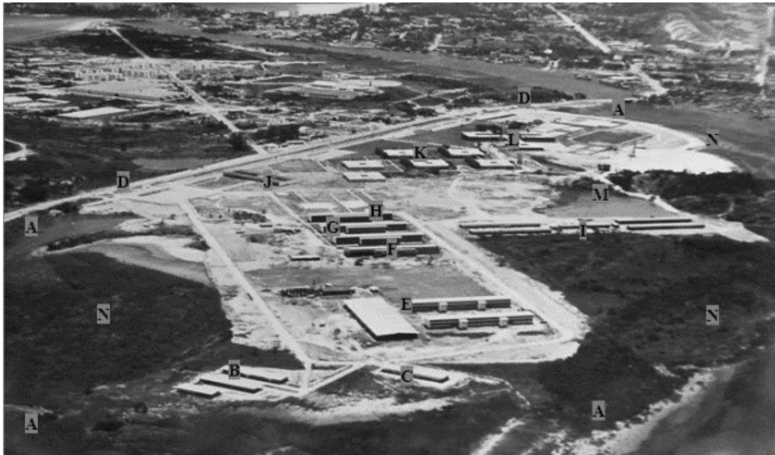
Figura 7 - Vista aérea parcial do Campus Universitário Alaor de Queiroz Araújo – sentido norte/sul (A), com os prédios construídos até meados da década de 1970, com destaque para os aterros realizados. B - Departamento de Administração/Prefeitura Universitária; C - Gráfica Universitária; D - Avenida Fernando Ferrari; E - Centro Tecnológico (CT's I e II/ITUFES); F - Centro de Educação (IC IV); G- Centro de Ciências Humanas e Naturais (IC's II e III); H – Centro de Ciências Exatas (IC I); I - Centro de Ciências Jurídicas e Econômicas (ED's I, II, III, IV e Administração); J - CWF; K - Centro de Artes (CEMUNI's I, II, III, IV, V e VI); L - Centro de Educação Física e Desportos; M - Lagoa e N - Manguezal de entorno. Fonte: Biblioteca Central da UFES/Seção de Coleções Especiais.
