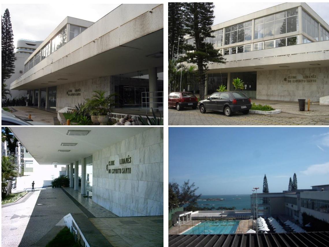
Figura 45, 46, 47 e 48: Perspectivas externas do Clube Libanês, sendo três da fachada frontal (45) (46) (47) e outra posterior, apreendida da parcela posterior do terreno (48), sendo perceptível a ampliação do terraço e do salão social do bloco superior.
