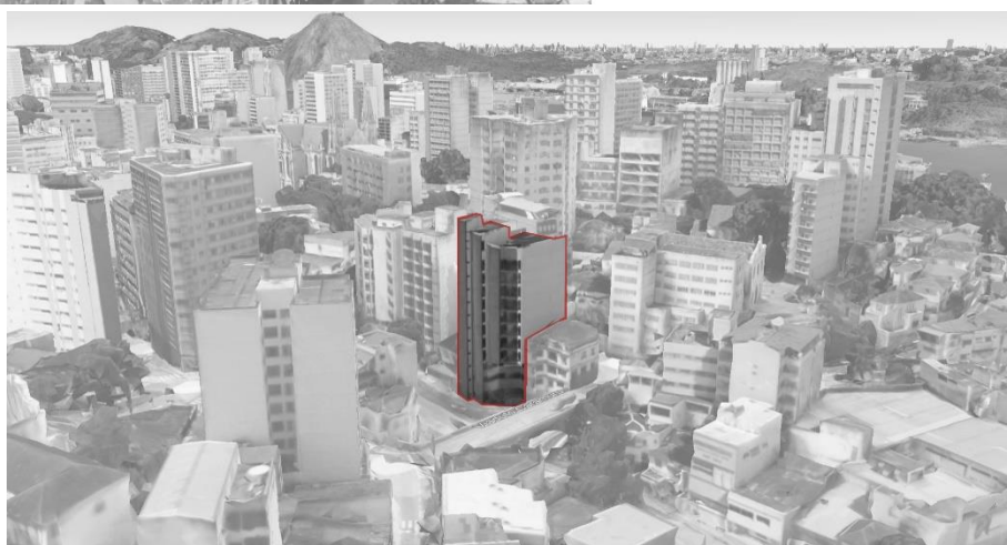
Figura 206 e 207: Ed. Amaury de Souza inserido no contexto urbano no bairro Centro, em Vitória-ES, destacando-se a sua fachada norte na figura 2, voltada ao Viaduto Caramuru, em primeiro plano.
