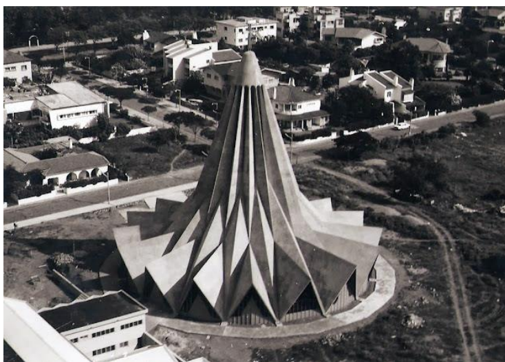
Figura 454: Igreja de Santo António de Polana (1959-62), de Nuno Craveiro Lopes, em Maputo, Moçambique. Fonte: https://housesofmaputo.blogspot.com/2015/10/igreja-catolica-de-santo-antonio-na.html , acesso em 19 julho 2022.
