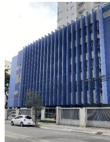
Figura 326: Fachada principal Ed. Pedra Azul, caracterizada pelos brises verticais. Fonte: Julia Meneghel, 2022.
