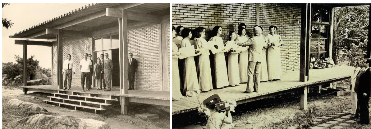
Figura 377 e 378: Escritório de Campo (1967), com destaque para a solução dos pilares externos. Fonte: acervo Maria do Carmo Schwab, reunido pela Profa. Clara Luiza Miranda (374) e arquivo Biblioteca Central da UFES (375).
