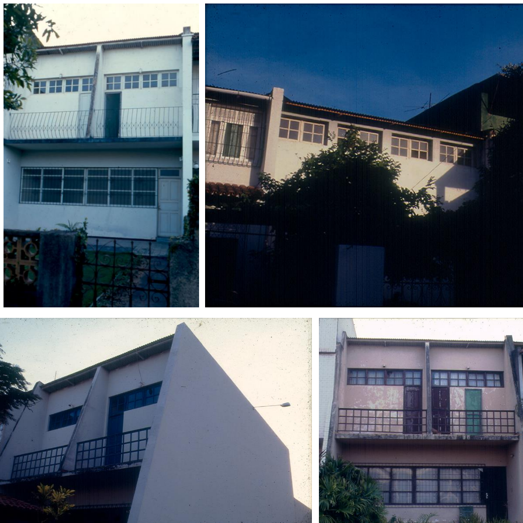
Figura 99, 100, 101 e 102: Fotos antigas do Conjunto Residencial Plácido Barcellos, com destaque para fachada principal e posterior.
