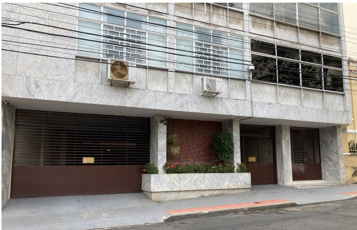
Figura 161, 162 e 163: Imagens atuais do Ed. Fabíola, com destaque para a fachada principal e os acessos renovados do térreo.
