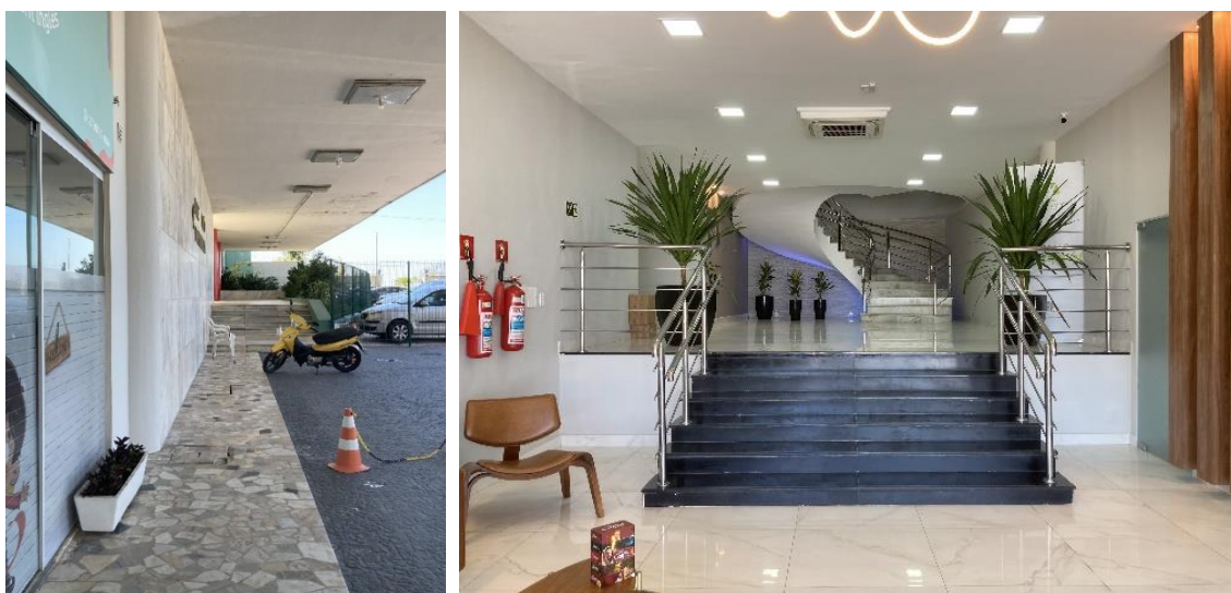
Figuras 66 e 67: Perspectiva frontal do térreo, com uma das portas de acesso à esquerda (66); e o hall social do clube renovados, com destaque ao fundo para a escada helicoidal (67).
