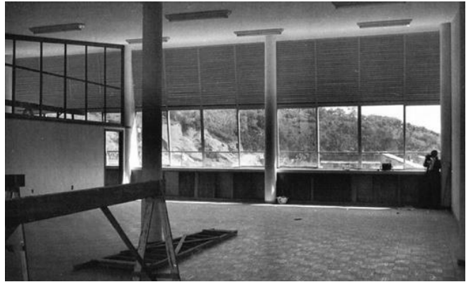
Figura 415 e 416: Vista interna Escola Politécnica, com destaque para o sistema estrutural, recuado do perímetro, de formato cilíndrico; e as esquadrias em veneziana. Fonte: TAUFNER; HERMANNY; LARANJA, 2017.
