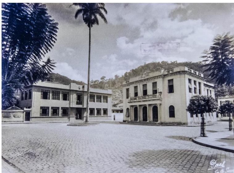
Figura 138: Antiga sede Prefeitura Municipal de Vitória, localizada no Centro da capital.
