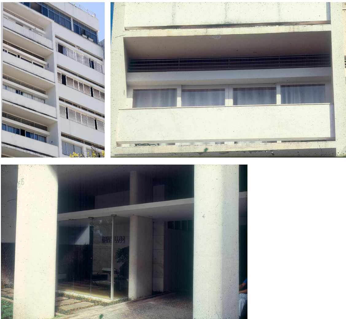
Figura 85, 86 e 87: Detalhe da fachada frontal do Ed. Barcellos, com destaque para a varanda com o guarda-corpo linear e brises fixos sobre esquadria (85) (86) e do térreo, ressaltando os grandes pilares, a laje rebaixada e o hall de acesso do edifício (87).
