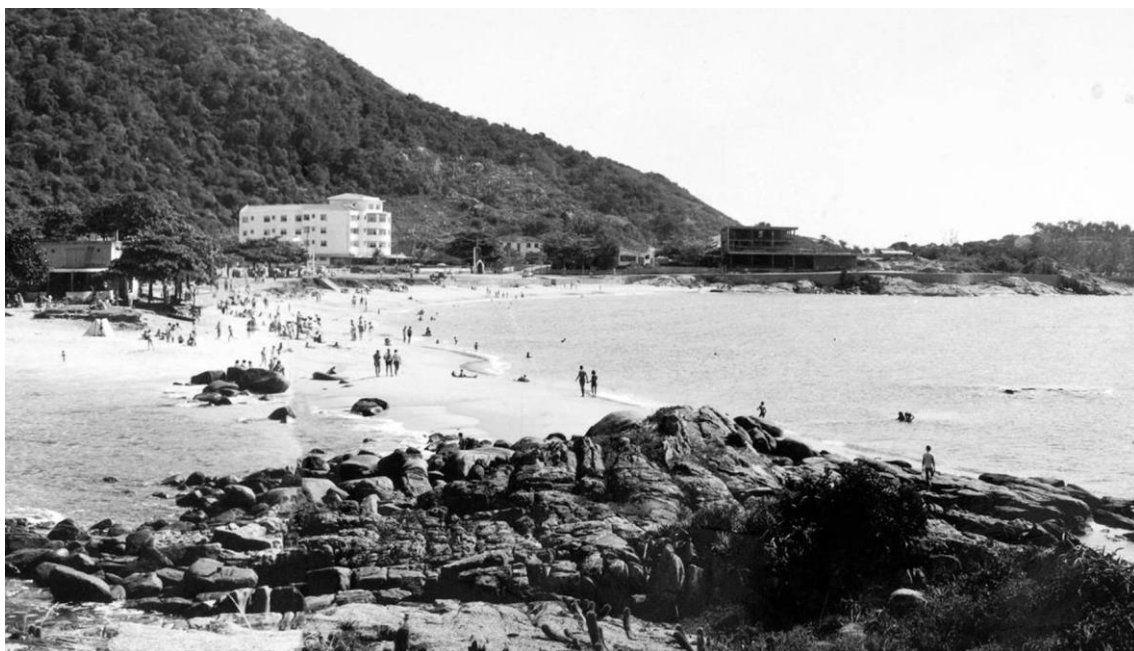
Figura 22: Perspectiva do Clube Libanês em construção e entorno imediato na década de 1960. Fonte: Arquivo Memória Capixaba, Fábio Pirajá.
