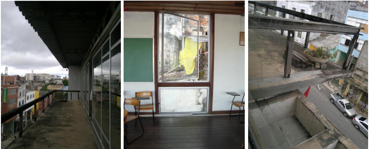
Figuras 467, 468, 469, 470 e 471: Levantamento fotográfico realizado por MENDES (2013) em 2012, com exceção da primeira imagem histórica, com destaque para as soluções em fachada do volume superior, desde materiais, elementos estruturais e cobertura (467); a escada de acesso ao salão principal (468); a varanda/terraço frontal (469); a esquadria do volume superior (470); e o detalhe do guarda-corpo, já muito danificado em 2012 (471). Fonte: MENDES, 2013.
