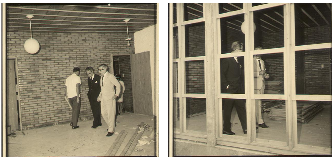
Figura 333 e 334: Interior do edifício Escritório de Campo (1967) ainda em obras, cujas vigotas de concreto e tijolos cerâmicos da laje são deixadas aparente internamente, indicado pela já alocação das luminárias.
