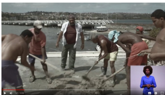
Figura 10: Equipe em obra
