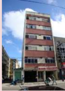
Edifício Lapa. Avenida Joana Angélica, Salvador.
