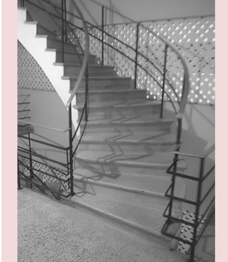
Figura 3.73- Edifício Cidade de Aracaju (1956) -escada principal do edifício ao lado dos cobogós do poço de iluminação e ventilação.
