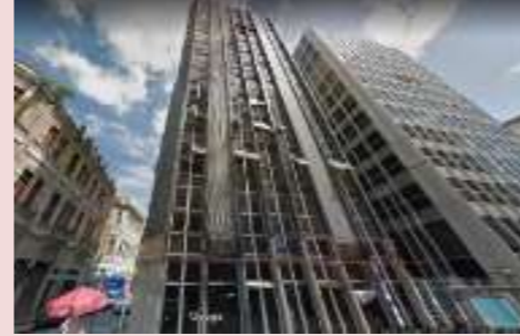
Edifício Comercial (s/d). Rua Pinto Martins- Comércio, Salvador.
