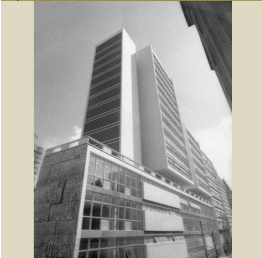
Figura 4.42- Detalhe do embasamento composto pelas lojas e painel de Carybé.
