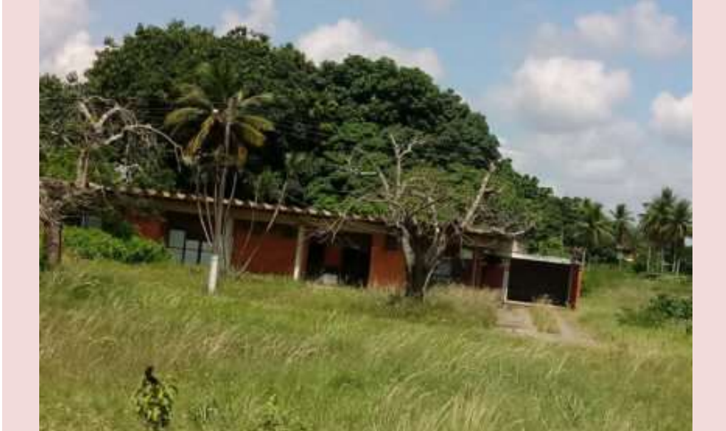
Figura 3.50 – Parque Rodoviário de Feira de Santana, já em estado de abandono (2020) 41
