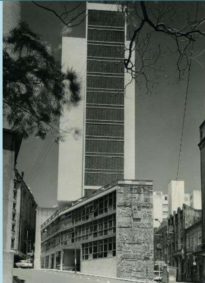
Figura 2.10- Edifício Bráulio Xavier (1964) - destaque para o platô, o terraço-jardim sobre ele e as torres acima, entre pilotis. R. Chile - Centro, Salvador
