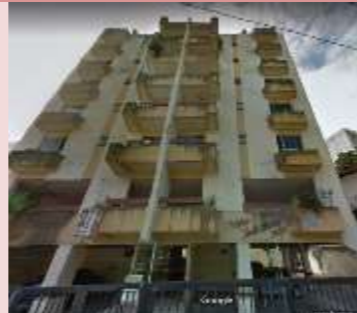
Edifício Santa Andreia. Avenida Centenário, Salvador.
