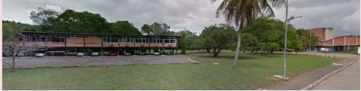
Figura 3.42- Bloco administrativo da Fábrica de azulejos IASA (1968). Pirajá, Salvador.
