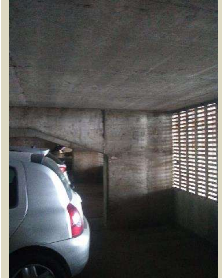
Figura 4.60- Espaço interno no pavimento tipo, com destaque para a estrutura e o fechamento em cobogós.
