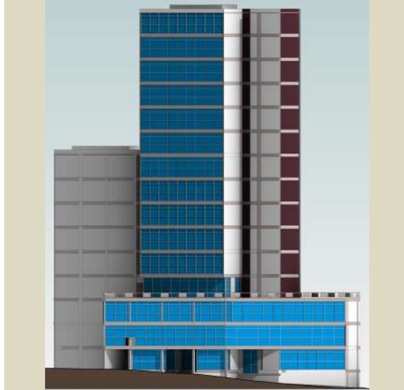
Figura 4.46- Fachada Norte do Edifício Desembargador Bráulio Xavier.
