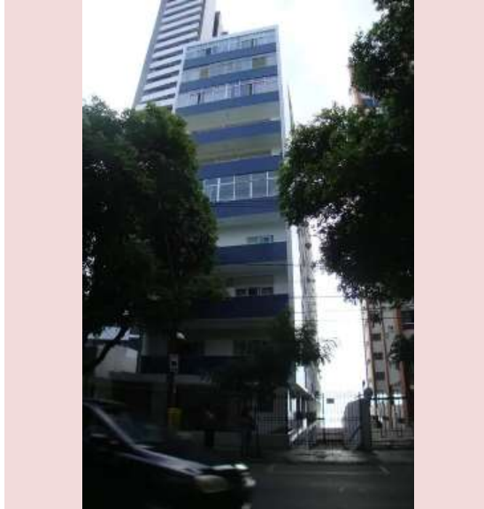
Figura 3.64- Edifício Koch atualmente-sem o brise vertical da proposta publicada. Corredor da Vitória, Salvador.
