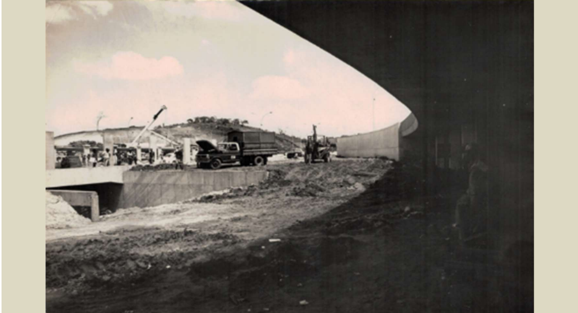
Figura 4.26- Obras da estação de transbordo da Rodoviária, com imagem no túnel de acesso-1981.
