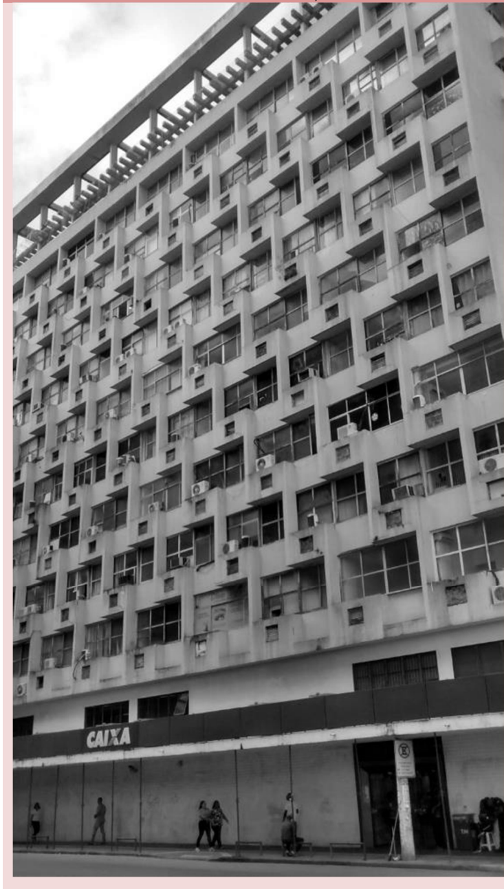
Figura 3.23 -Edifício Cervantes (1963). Av. Estados Unidos- Comércio, Salvador.
