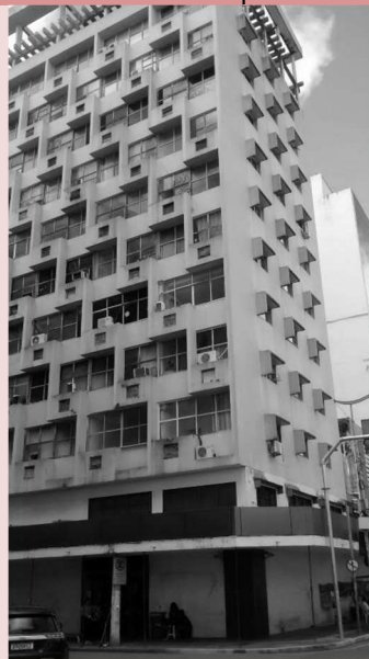
Figura 3.75- Edifício Cervantes (1963) –fachada com detalhe da caixa de ar-condicionado que forma um mosaico compondo toda a fachada de acesso. O térreo se apresenta descaracterizado.
