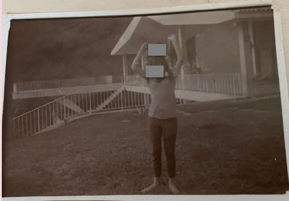
Figura 3.55 44 - Casa de Dr. Francisco Serra com destaque para a escada e o pilar inclinado apoiando a grande sacada da varanda.
