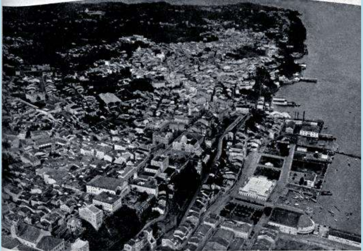
Figura 2.3- Imagem aérea de Salvador em 1923- com a igreja da Sé ainda de pé.
