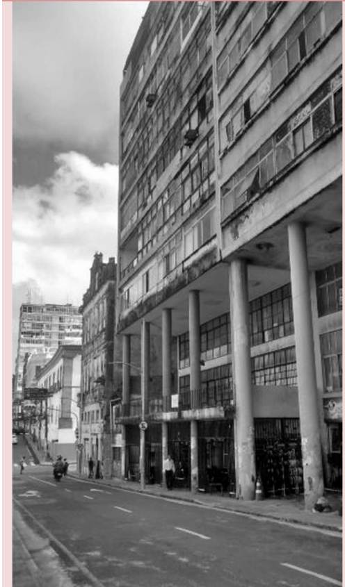
Figura 3.38 - Edifício Churchill (s/d). Viaduto da Sé, Salvador.
