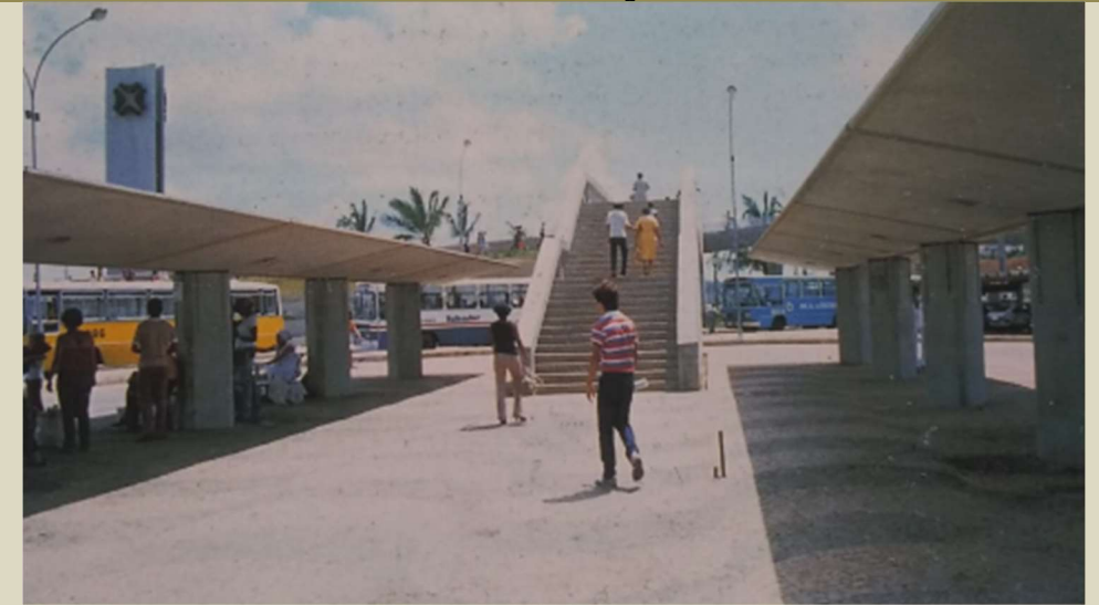
Figura 4.28- Estação de transbordo da Rodoviária com escadaria e ponte para pedestres, vista de outro ângulo.
