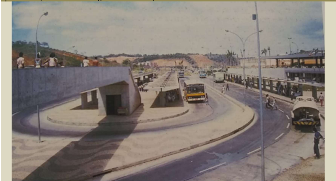
Figura 4.27- Estação de transbordo da Rodoviária com escadaria e ponte para pedestres conectada a passarela que dá acesso ao Iguatemi e a Estação.
