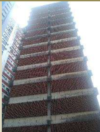
Figura 4.35- Edifício Garagem Central (s/d)
