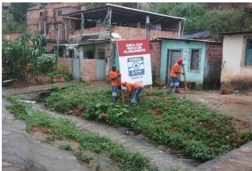
Figura 3: Instalação de placas da CODESAL na Baixa de Santa Rita, Salvador, Bahia.
