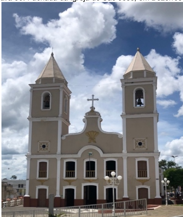
Figura 36: Fachada da Igreja de São José, em Bezerros-PE.
