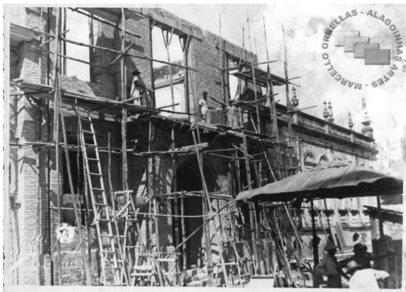
Figura 7 – Construção da Prefeitura de Alagoinhas - predomínio de trabalhadores negros nos trabalhos braçais
