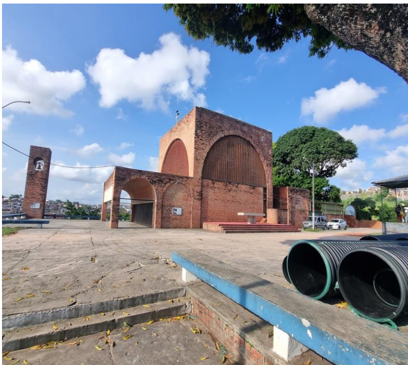
Figura 23 – Vista externa da Paróquia N. Sra. dos Alagados e São João Paulo II
