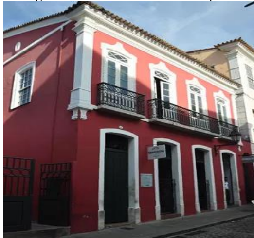
Figura 1 – Fachada do Museu Tempostal.
