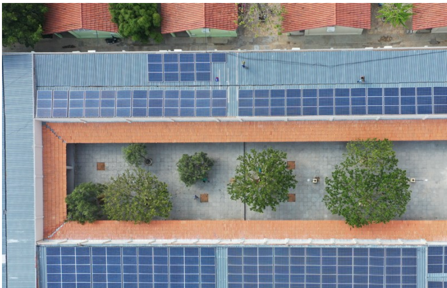
Figura 21: Sistema Fotovoltaico do campus Guanambi. Vista Superior Fonte: Fotografia obtida in-loco através de drone
