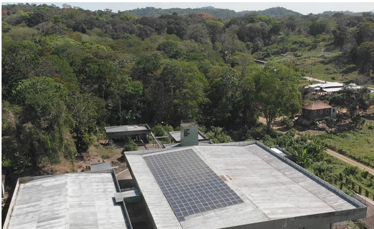
Figura 16: Visão do entorno do bloco CTA do campus Uruçuca. Fonte: Fotografia obtida in-loco através de drone
