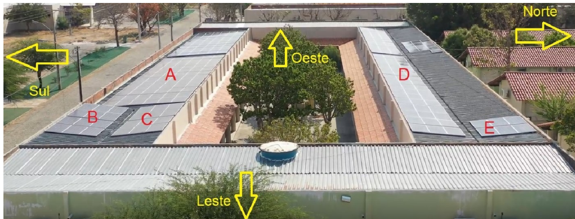
Figura 8: Inclinações e direcionamentos do telhado do Pavilhão de aulas 3 Fonte: Fotografia obtida in-loco através de drone
