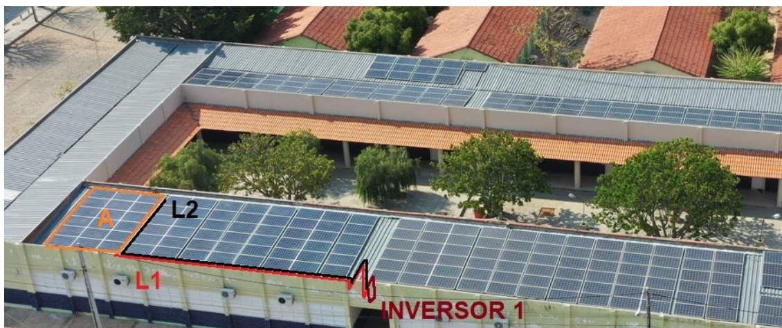
Figura 13: String A, relativo ao primeiro inversor Fonte: Fotografia obtida in-loco através de drone
