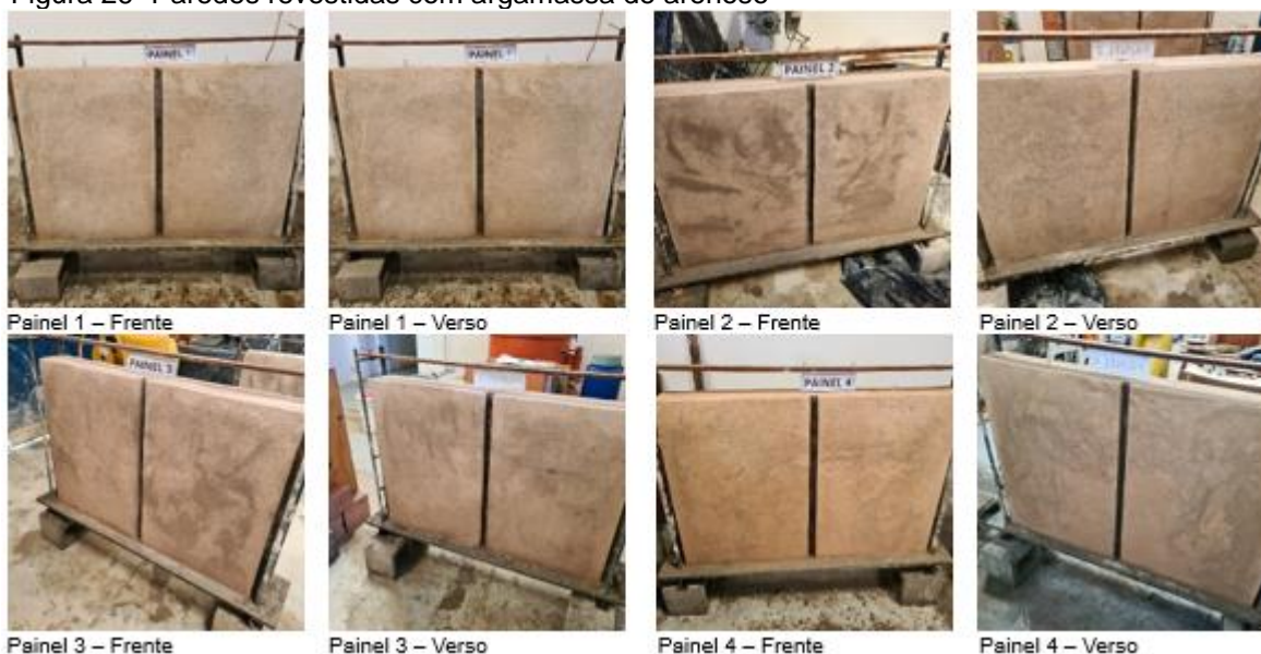
Figura 26- Paredes revestidas com argamassa de arenoso
