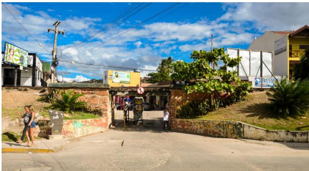
Figura 11: Pontilhão da linha férrea antes da demolição.
