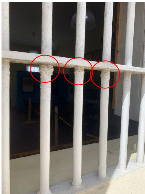
Figura 25: Grades da Cella 01 restauradas após deterioração.
