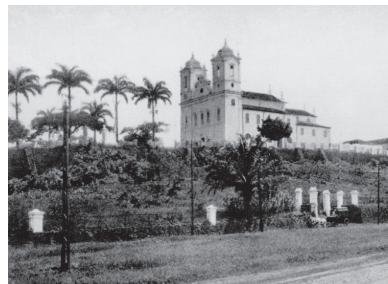
Fotografia 47 – Muro de vedação e embelezamento da encosta. Fonte: Arquivo Museu Tempostal.
