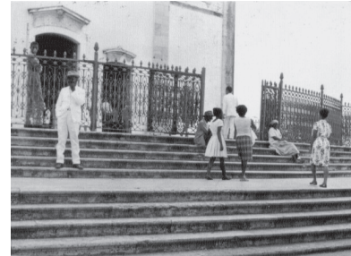
Fotografia 36 – Grade do adro da igreja do Bomfim – fachada sudoeste. Fonte: Arquivo do CEAB.
