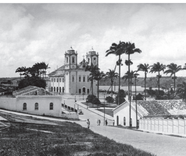
Fotografia 44 – Largo do Bonfim e ruas adjacentes, depois da obra de 1900. Fonte: Falcão, 1940.
