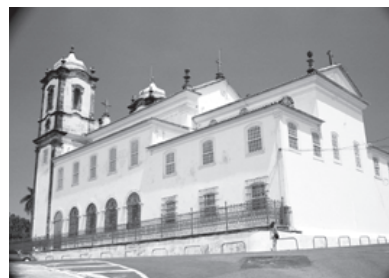
Fotografia 26 – Fachada Sudeste vedação das varandas e novos telhados. Foto: Luis Teixeira, 2002.
