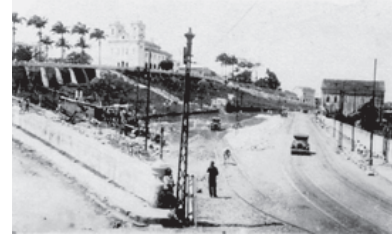
Fotografia 51 – Obras na Baixa do Bonfim, 1930. Fonte: Acervo particular da Família Marback.
