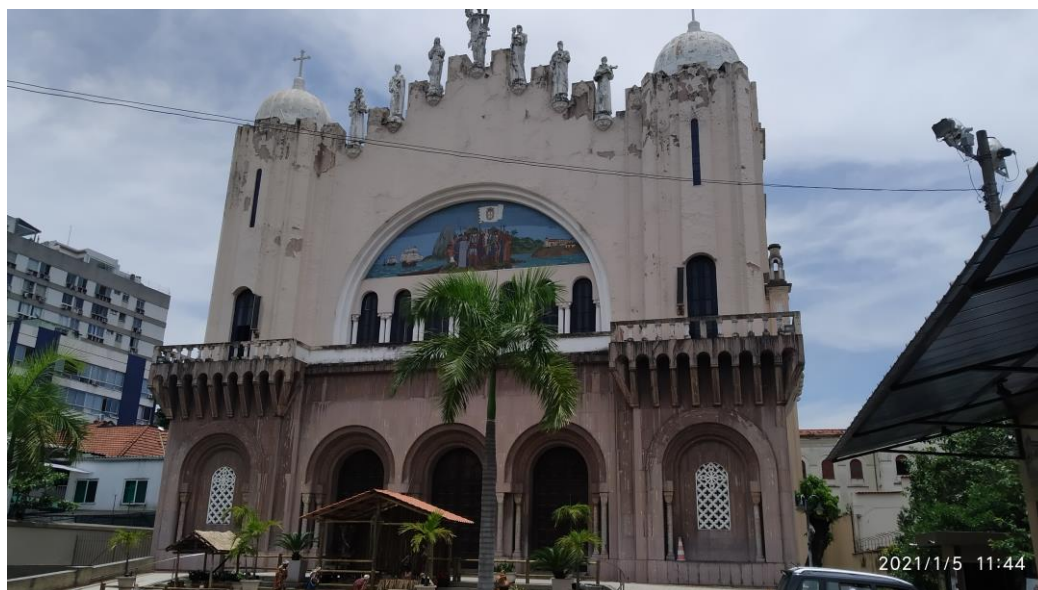
Figura 20 – Fachada da Igreja de São Sebastião do Rio de Janeiro, Tijuca, 05.01.2021
