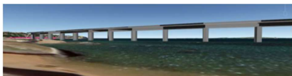
Terminal Calçada 1 Dir. São Joaquim
