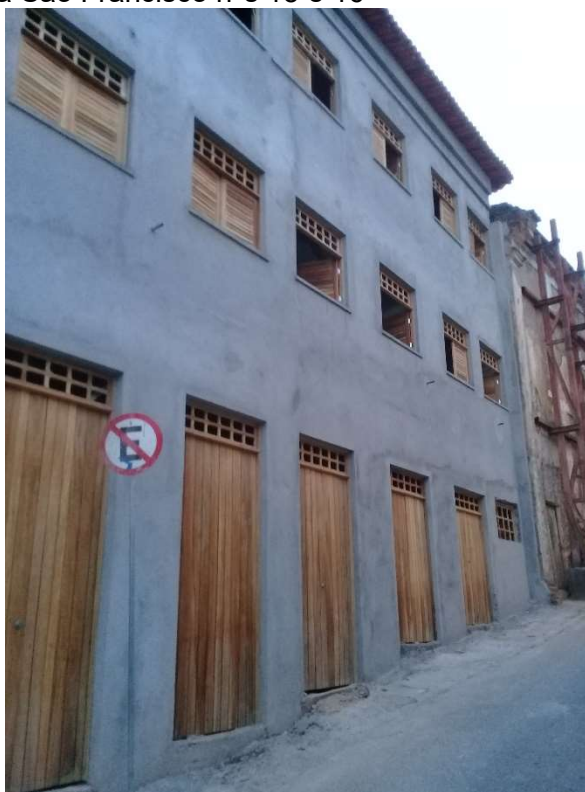
Figura 9. Obras em andamento no imóvel na esquina da rua Guedes de Brito com a São Francisco n°s 15 e 16
