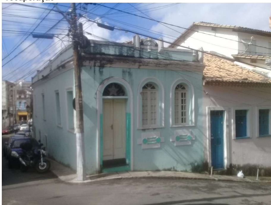
Figura 7. Imóvel nº 10 da Rua São Francisco depois da recuperação
